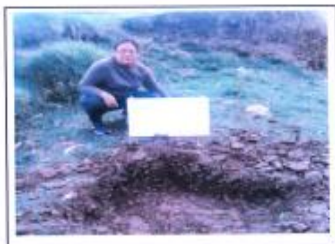
FOTO 02.- C-1, ESTRIBO DERECHO, COORD. 476661.00 m E – 8660341.00 m S
