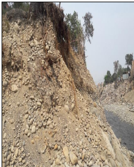
Fotografía N° 8- Se observa que la margen derecha del río Rímac es de material de relleno.
