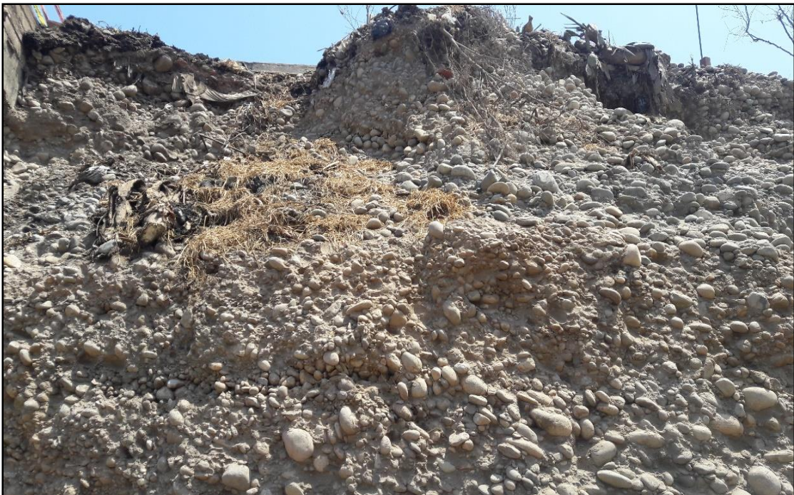
Fotografía N° 2.- Se observa en el tipo de suelo que son mezclas de materiales areno gravoso sueltos y canto rodado de 3" poco consolidados.
