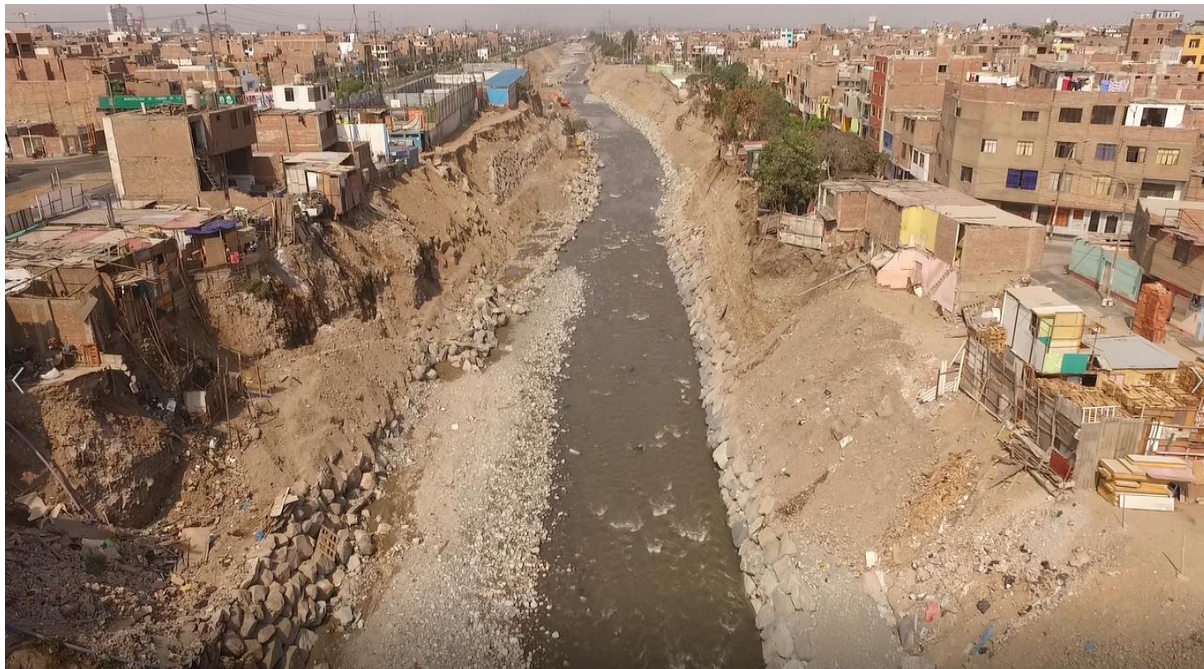
Fotografía N° 12.- Se observa que las margen derecha (Distrito de San Martín), hay viviendas en gran vulnerabilidad.
