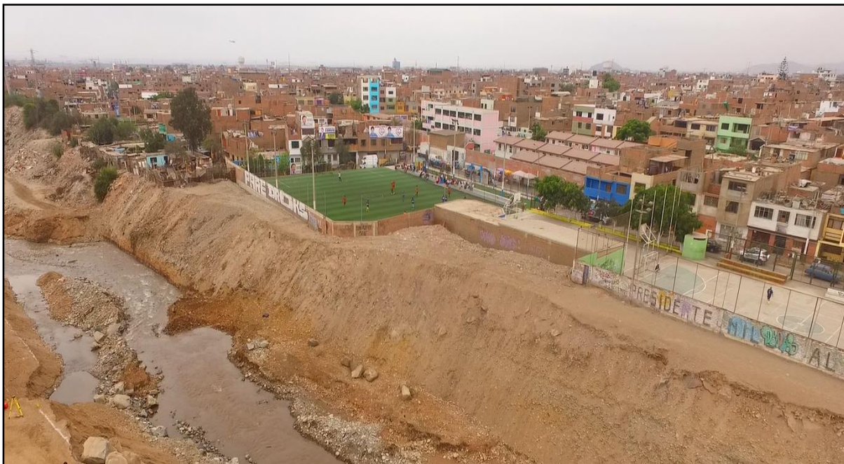
Fotografía N° 11.- Se observa la infraestructura, que es vulnerable al peligro de deslizamiento (erosión)
