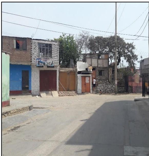
Fotografía N° 6- Se observa viviendas cerca de la margen derecha del río Rímac
