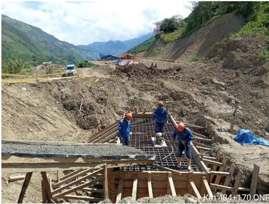
Vaciado de concreto  $f'c$  280 kg/cm<sup>2</sup>
