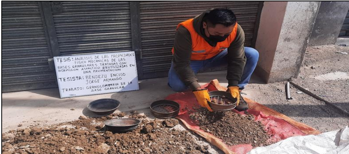
Fotografía 7. Ensayo de granulometría de material de base.
