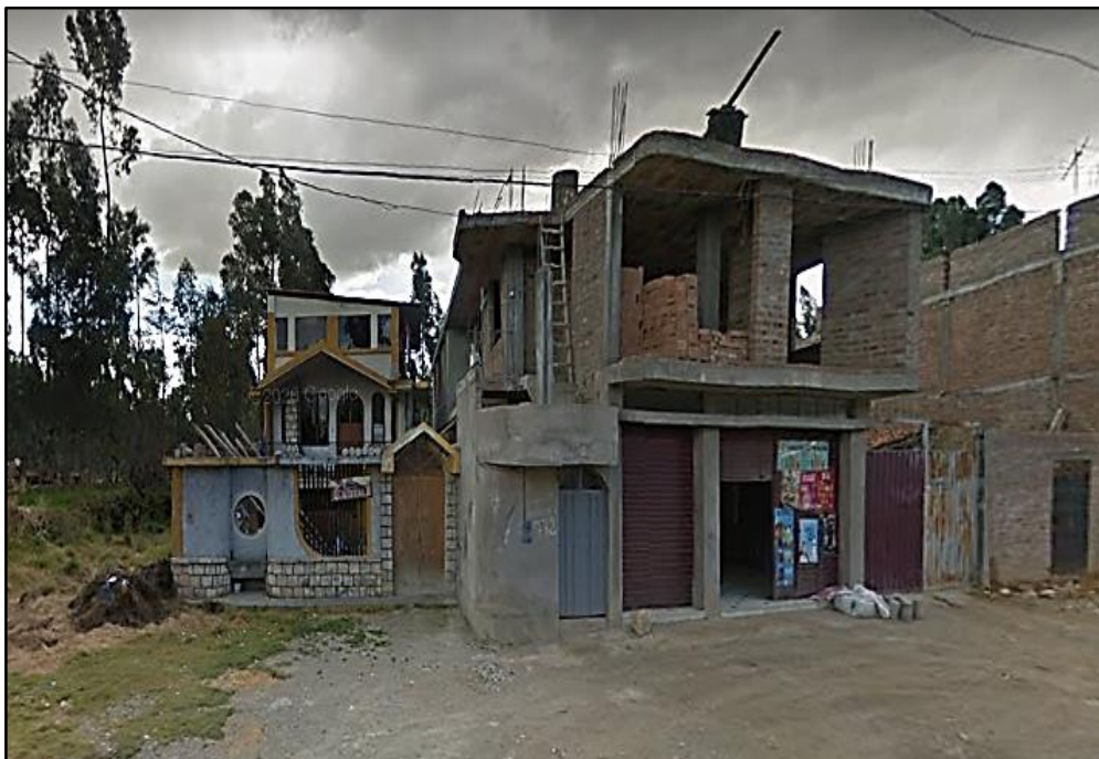
Fotografía 2. Vista frontal del laboratorio de Ensayos.
