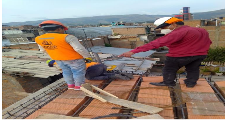
Figura 137 El Ingeniero residente dando pautas de trabajo en altura.
