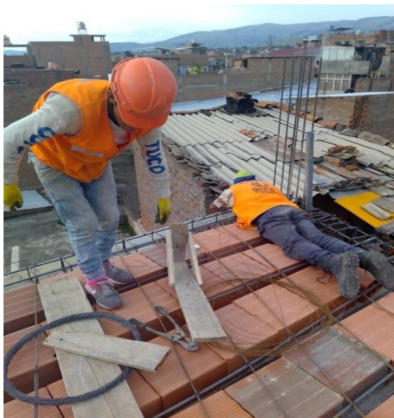
Figura 21. Trabajos en altura
