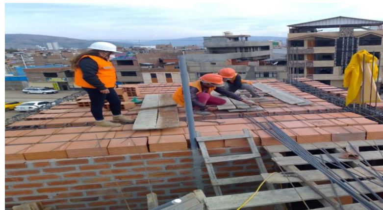
Figura 138. Inspeccionando los procedimientos de la partida de losas aligeradas.
