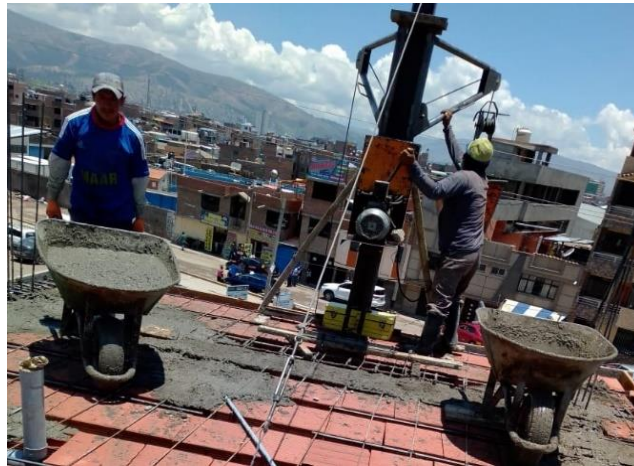
Figura 16. Trabajo en altura
