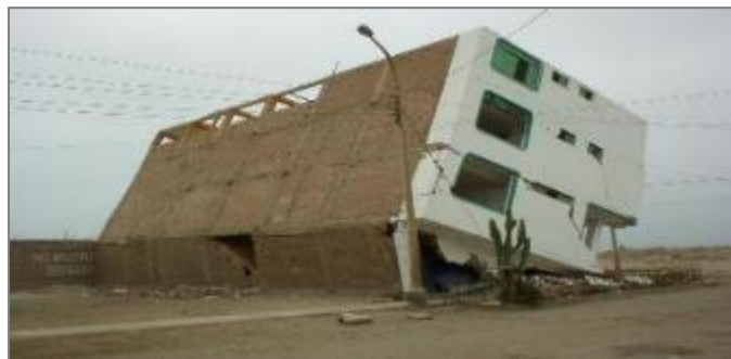
Figura 6: Desplazamiento de la cimentación Fuente: Terremoto de Ica, 2007.
