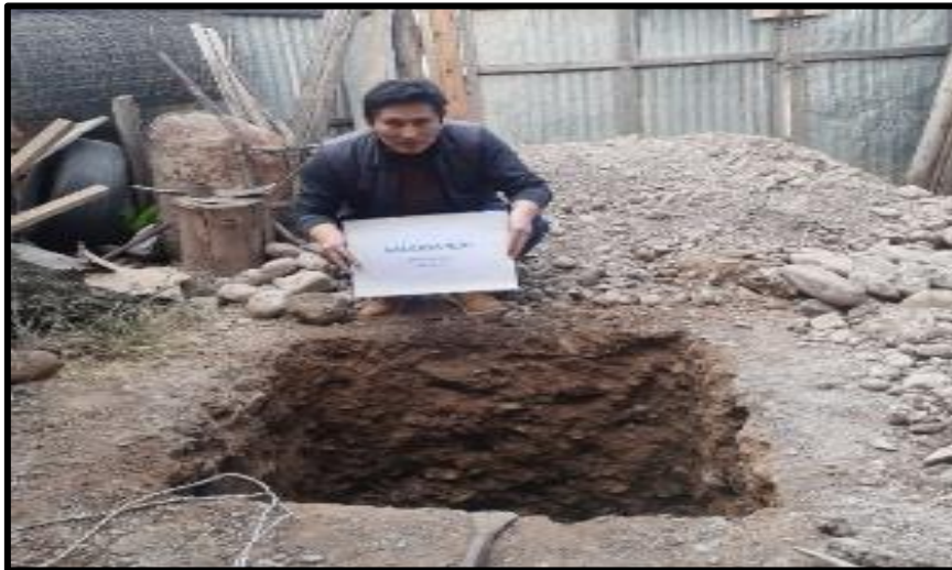
Fotografía 6: Perfil de suelo granular analizado
