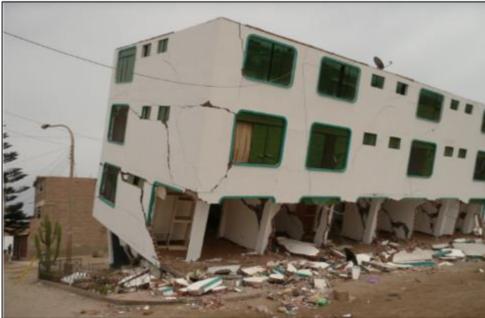
Figura 1: Colapso de columnas el edificio Montecarlo, Venezuela 1967. Fuente: Phd. Genner Villarreal Castro.
