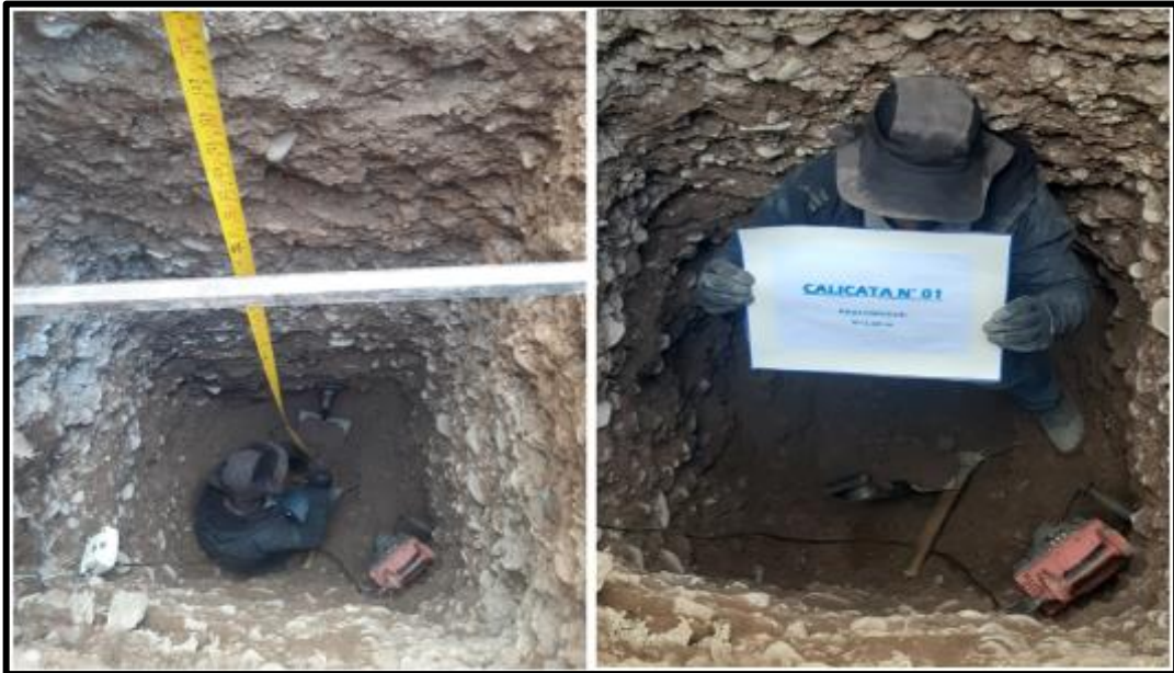
Fotografía 1: Profundidad de excavación para Calicata 1 - Suelo granular S2
