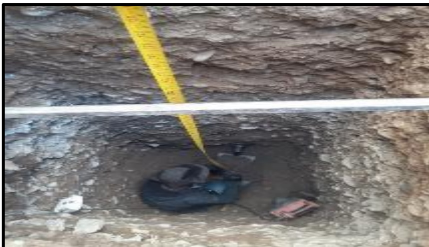
Fotografía 7: Profundidad excavada P=Df+1.5B = 3.00 m.
