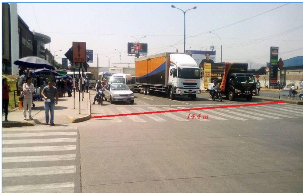
Figura 19: Medida de la Carretera Central, Este-Oeste
