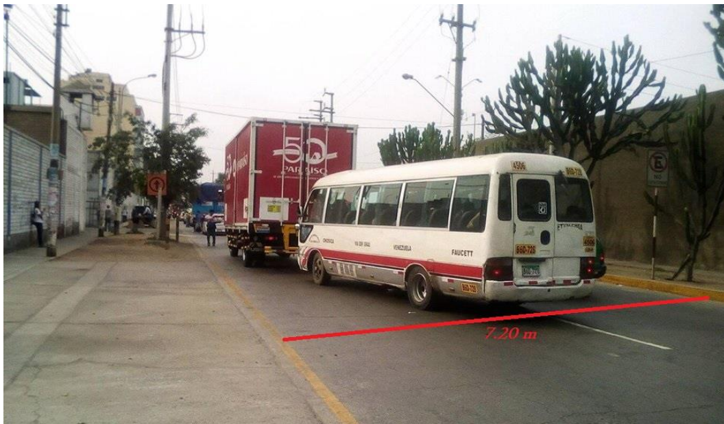
Figura 20: Medida de la vía del acceso Minería a la Carretera Central
