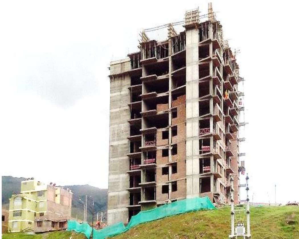
Figura 11 - Edificio en construcción Lomas de San Antonio – Huancayo – Junín.
