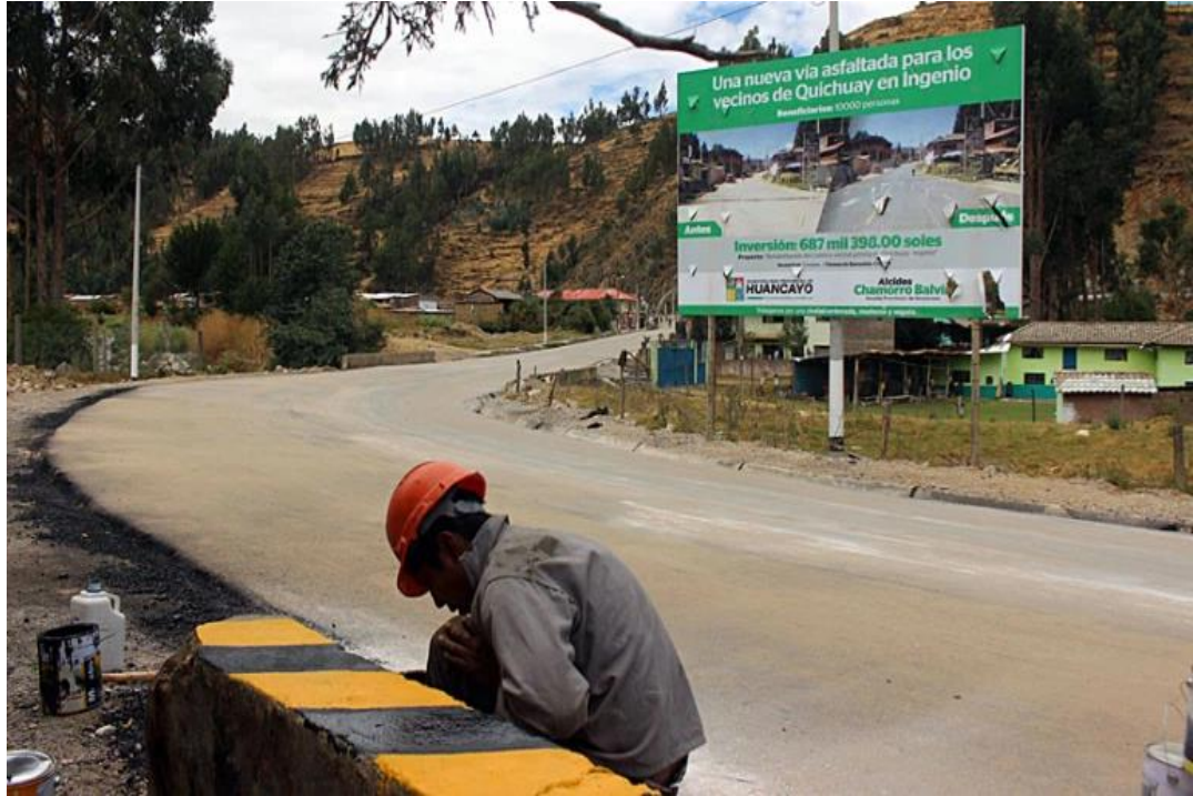
Figura 12 - Pavimentación carretera Quichuay – Ingenio.
