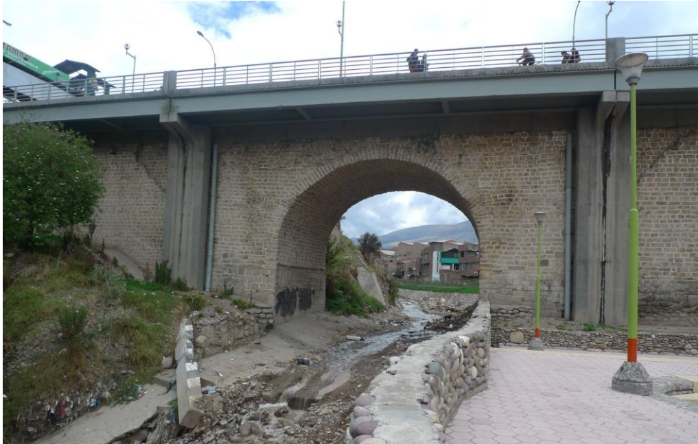
Figura 10 – Puente Los Andes - El río Shullcas, en Huancayo (Junín),
