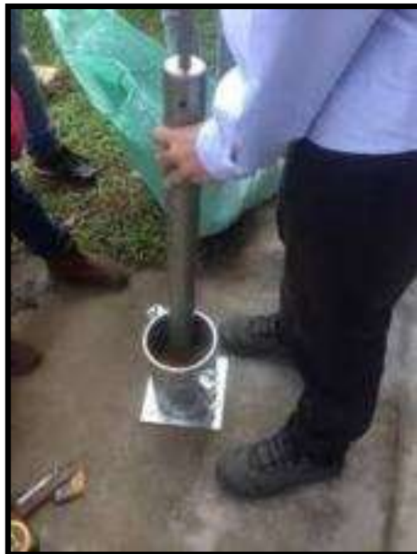
Imagen 6: Compactación de material préstamo
