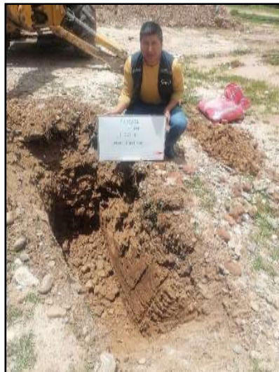
Imagen 11: Vista de la calicata C-2.
