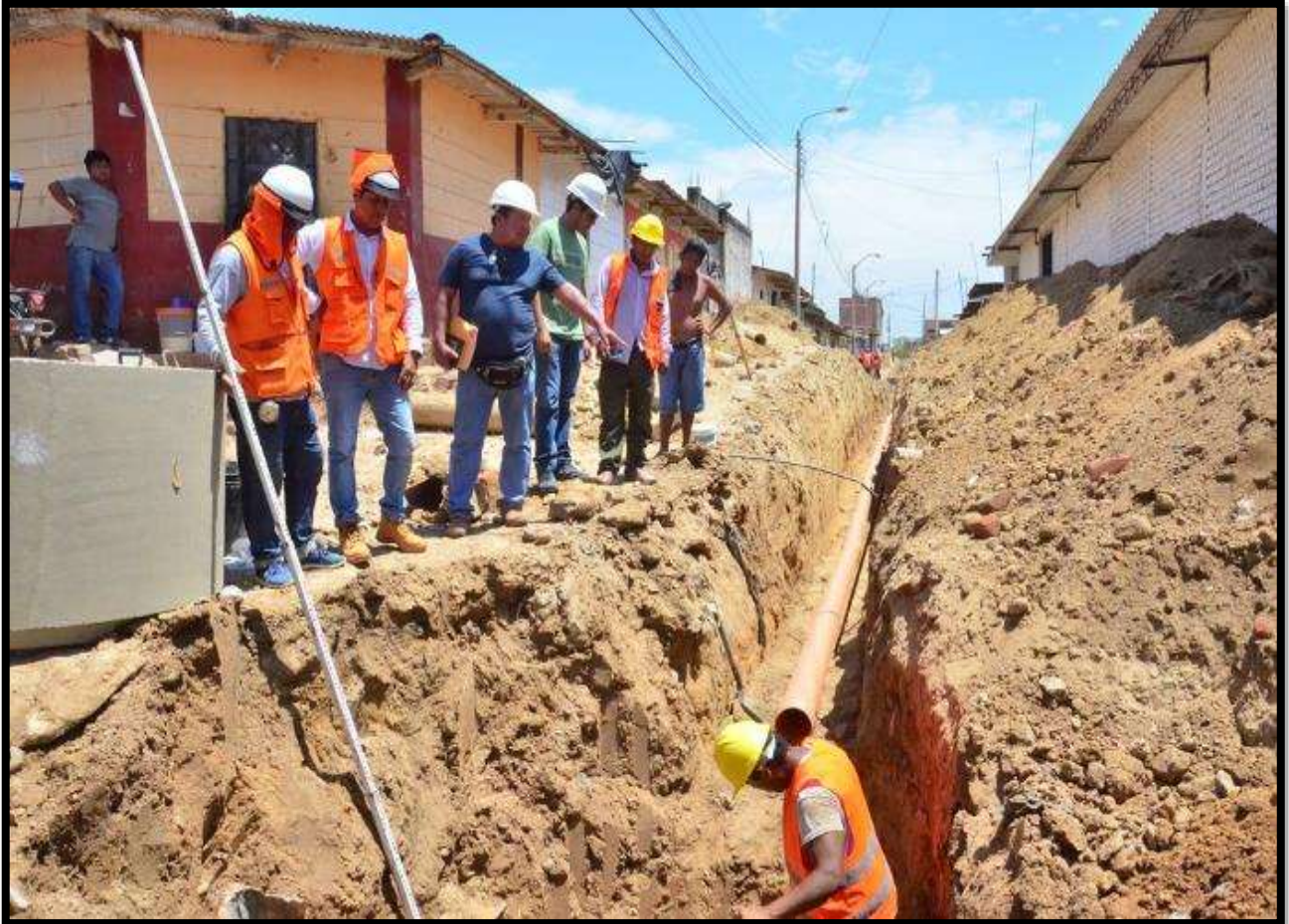
Imagen N° 06: en la imagen se visualiza los trabajos previos a la pavimentación de la Av. Los Héroes, el cual es el cambio de tubería por diversos motivos.
