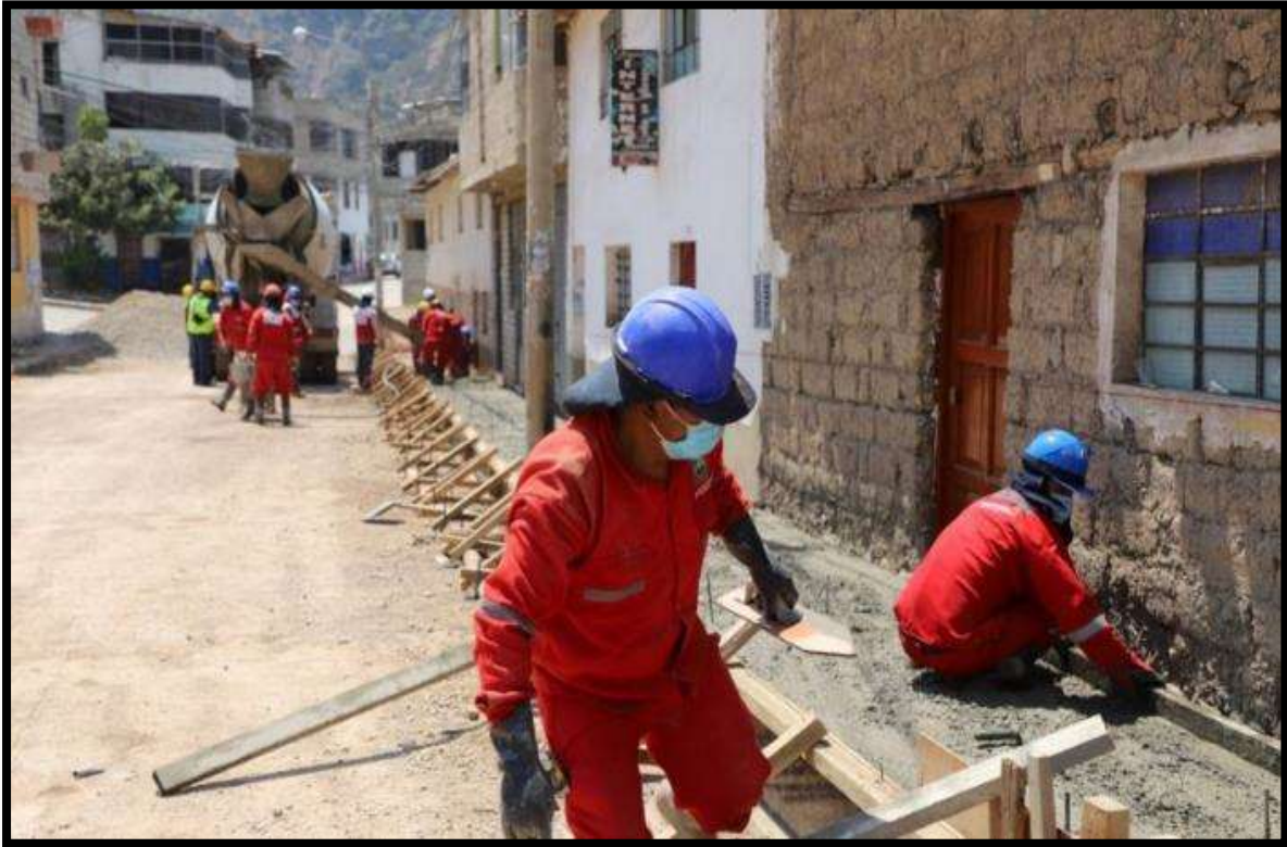
Imagen N° 05: en la imagen se visualiza la base de pavimento y colocado de concreto vereda.
