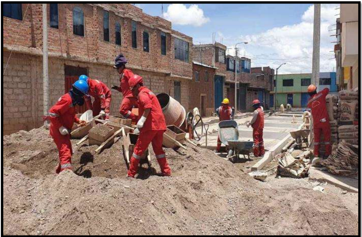
Imagen N° 04: en la imagen se visualiza el colocado de concreto del pavimento rígido.
