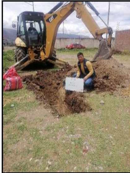
Imagen 10: Vista de la calicata C-1
