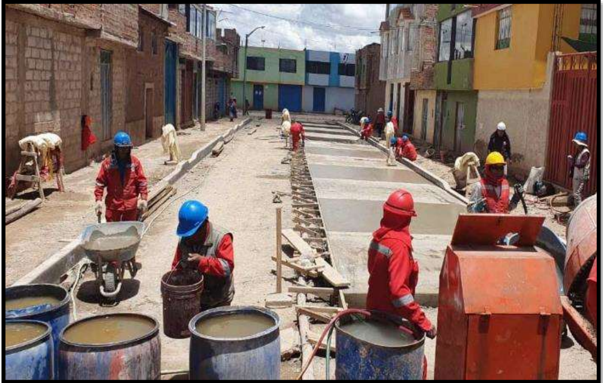
Imagen N° 03: en la imagen se visualiza el trabajo de encofrado y colocado de concreto del pavimento rígido.
