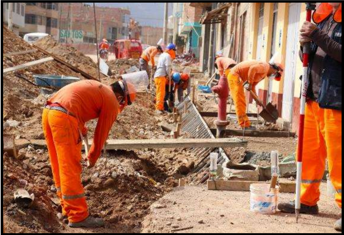
Imagen N° 01: en la imagen se visualiza el trabajo de base de veredas.
