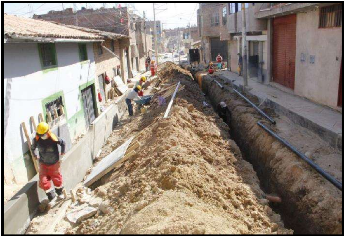
Imagen N° 06: en la imagen se visualiza los trabajos previos a la pavimentación de la Av. Los Héroes, el cual es el cambio de tubería por diversos motivos.
