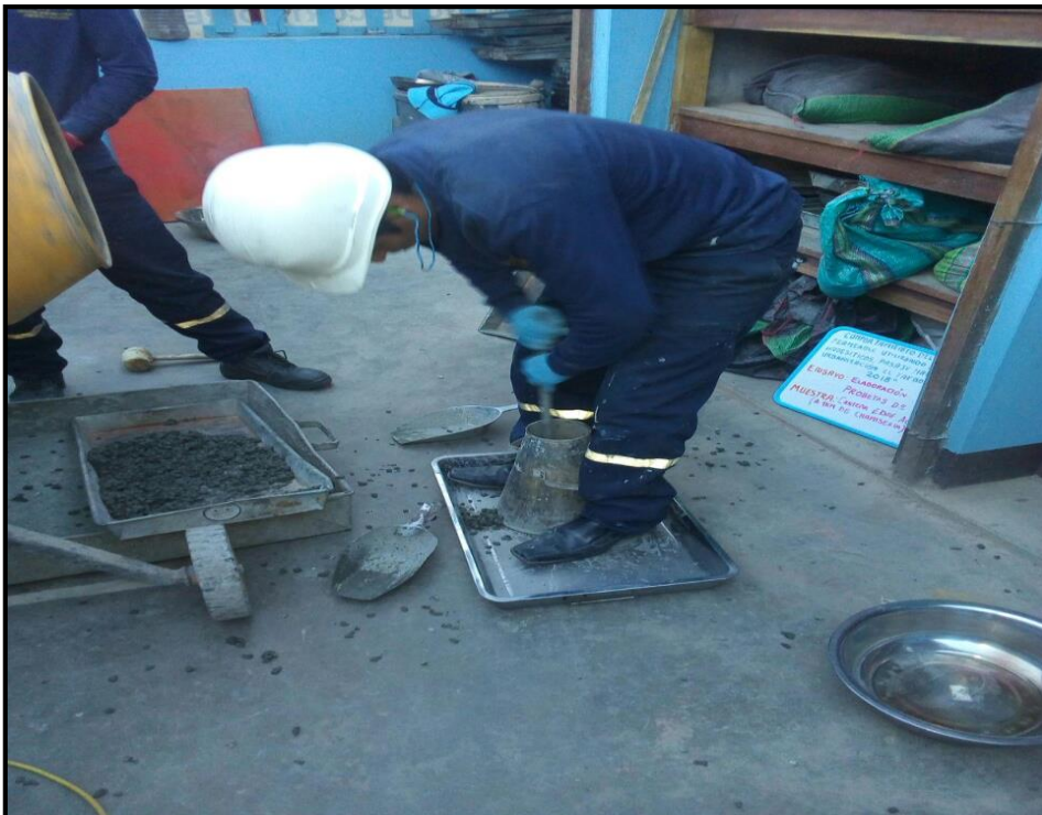
Imagen N° 8 Ensayo de asentamiento de 0-2". Con agregado de 1/2".
