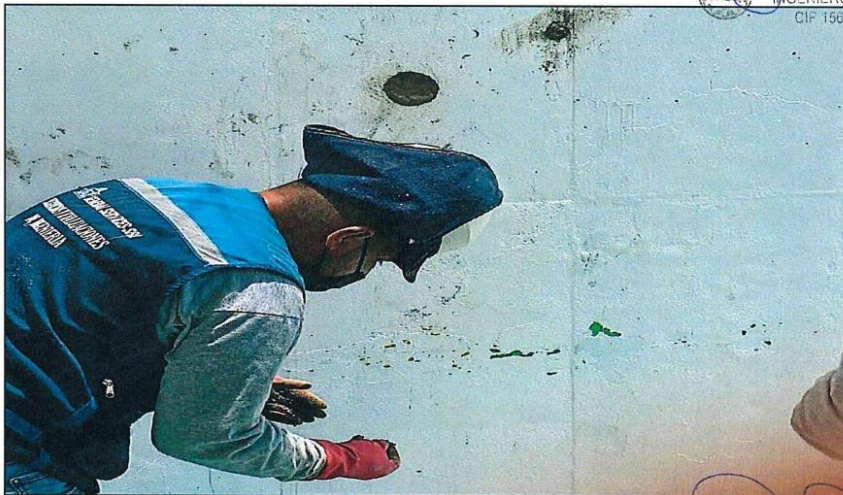
Personal Encargado realizando el Resane del producto de la Extracción de Testigos de Concreto
