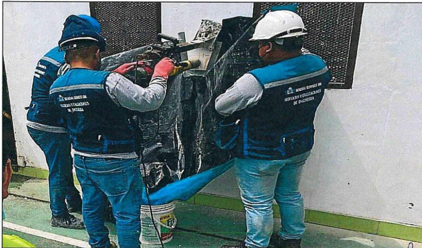
Personal Encargado realizando la EXTRACCION DE TESTIGO DE CONCRETO en PLACA (DIAMANTINA N.º 02)
