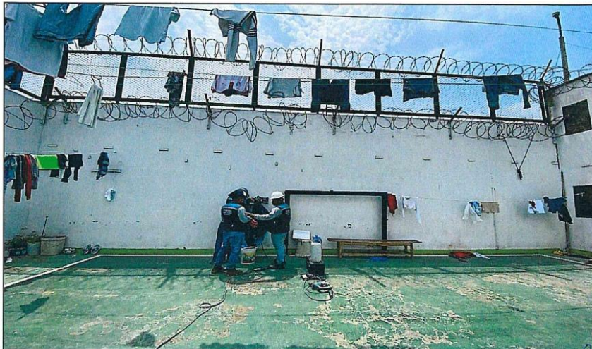
Personal Encargado realizando la EXTRACCION DE TESTIGO DE CONCRETO en PLACA (DIAMANTINA N.º 03)
