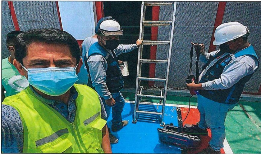
PERSONAL ENCARGADO DE ESCANEADO DE ACERO EN PLACAS DE PABELLON N.º 07 - PATIO
