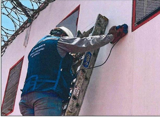
Figura N°05. Verificación en Placa el diámetro de Acero
