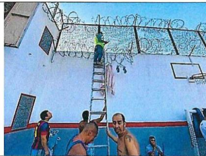
Toma de datos Vista 3 (Fondo Muro Perimétrico)
