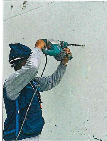
Personal Encargado realizando la Verificación de Acero en PLACAS y Punto de Anclaje para Equipo a utilizar.
