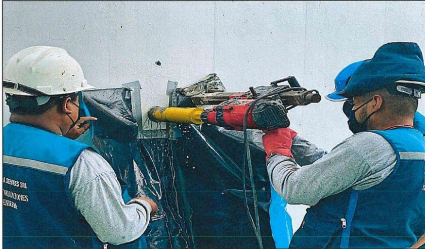
Personal Encargado realizando la EXTRACCION DE TESTIGO DE CONCRETO en PLACA (DIAMANTINA N.º 01)
