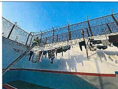
Toma de datos Vista 4 (Lateral Muro Perimétrico)
