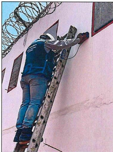
Personal realizando el Escaneo de ACERO en PLACAS – Patio de Pabellón N.º 07
