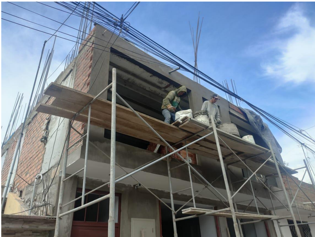
FOTOGRAFÍA 2: Tarrajeo de fachada de vivienda N° 07
