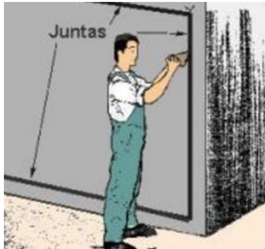
Figura 0.7 Bruñado en juntas.
