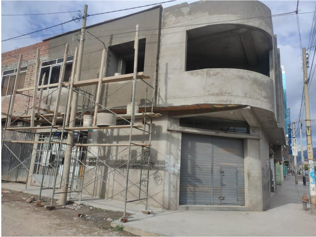
FOTOGRAFÍA 1: Tarrajeo de Fachada de vivienda N° 03
