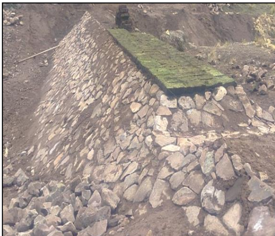
Figura 24. Imágenes de los detalles de dique de tierra y acabados
