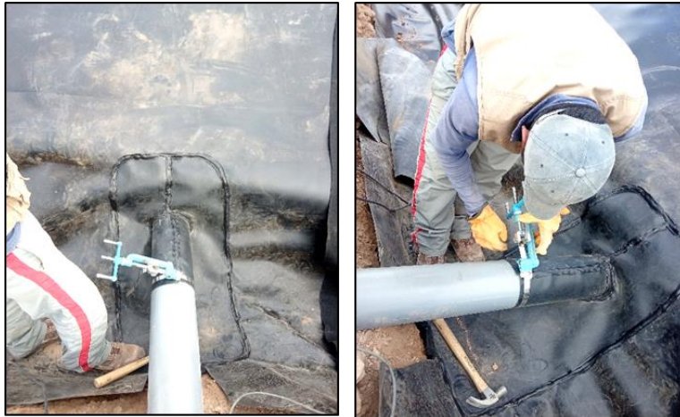
Figura 31. Detalles de unión de la tubería de descarga con la geomembrana
