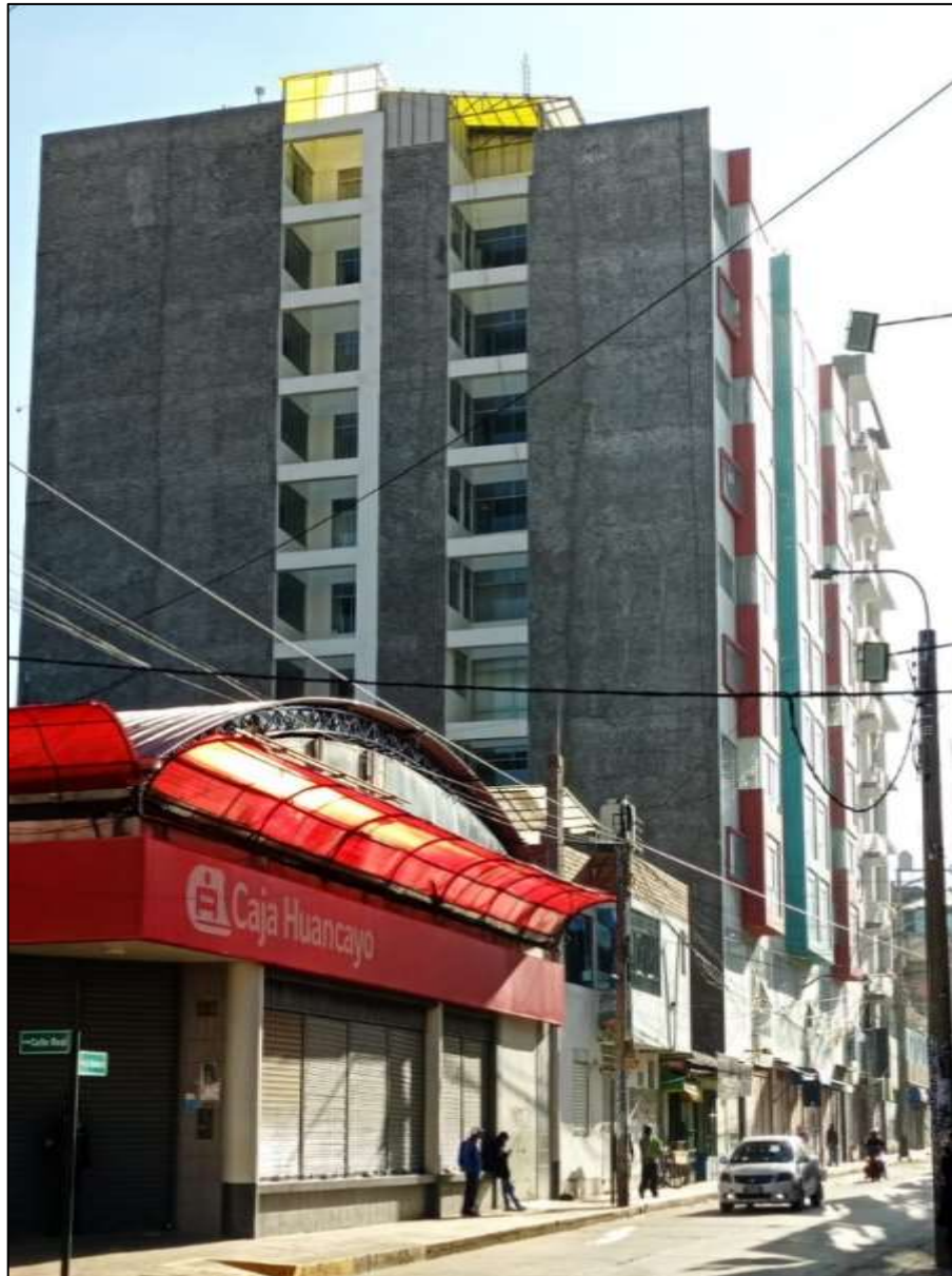
Figura N° 23. Edificación de 10 niveles (vista lateral) ubicado en el Jr. Huánuco N°350, Huancayo
