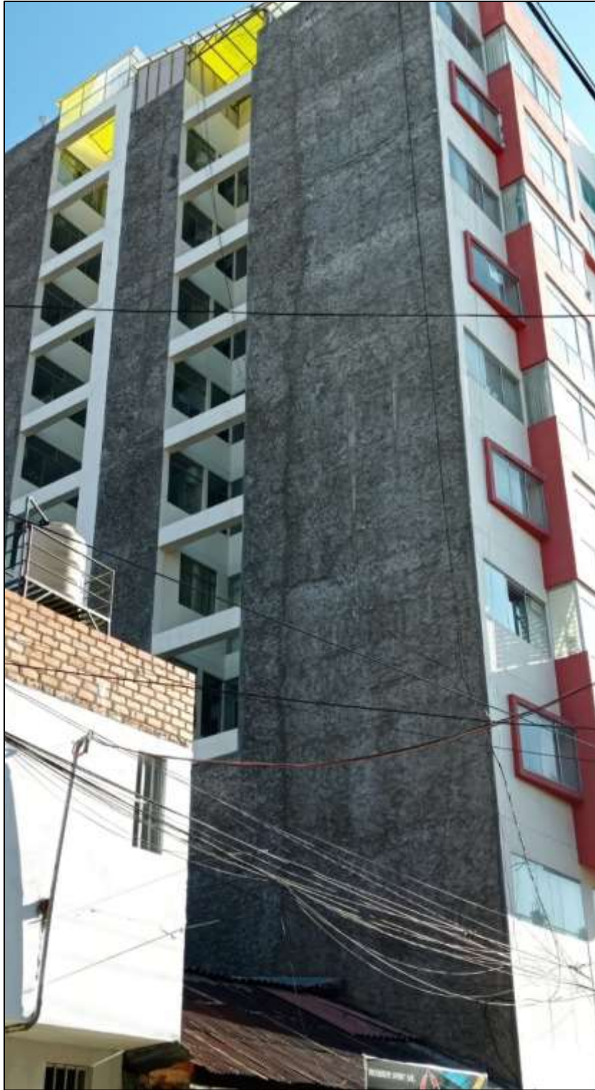
Fotografía N° 3. Vista lateral de la edificación
