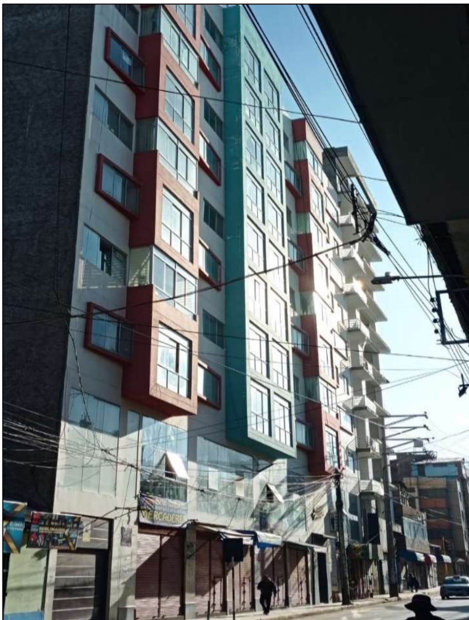
Figura N° 22. Edificación de 10 niveles (vista frontal) ubicado en el Jr. Huánuco N°350, Huancayo
