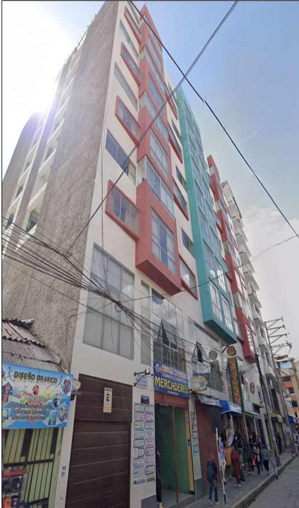
Fotografía N° 4. Vista frontal de la edificación
