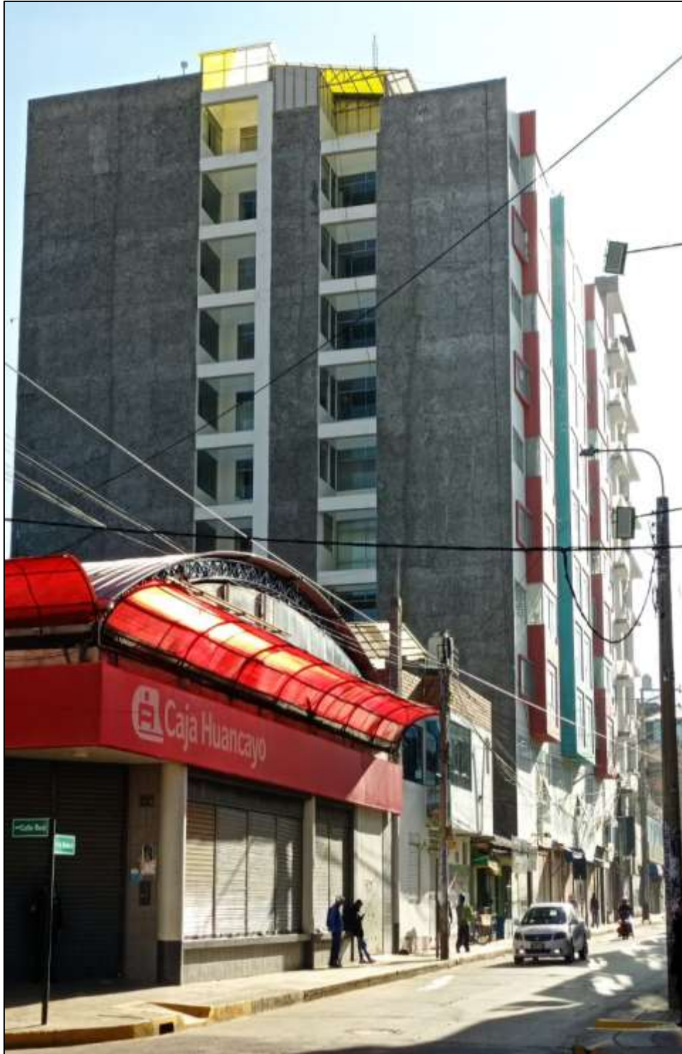
Fotografía N° 1. Vista lateral de la edificación
