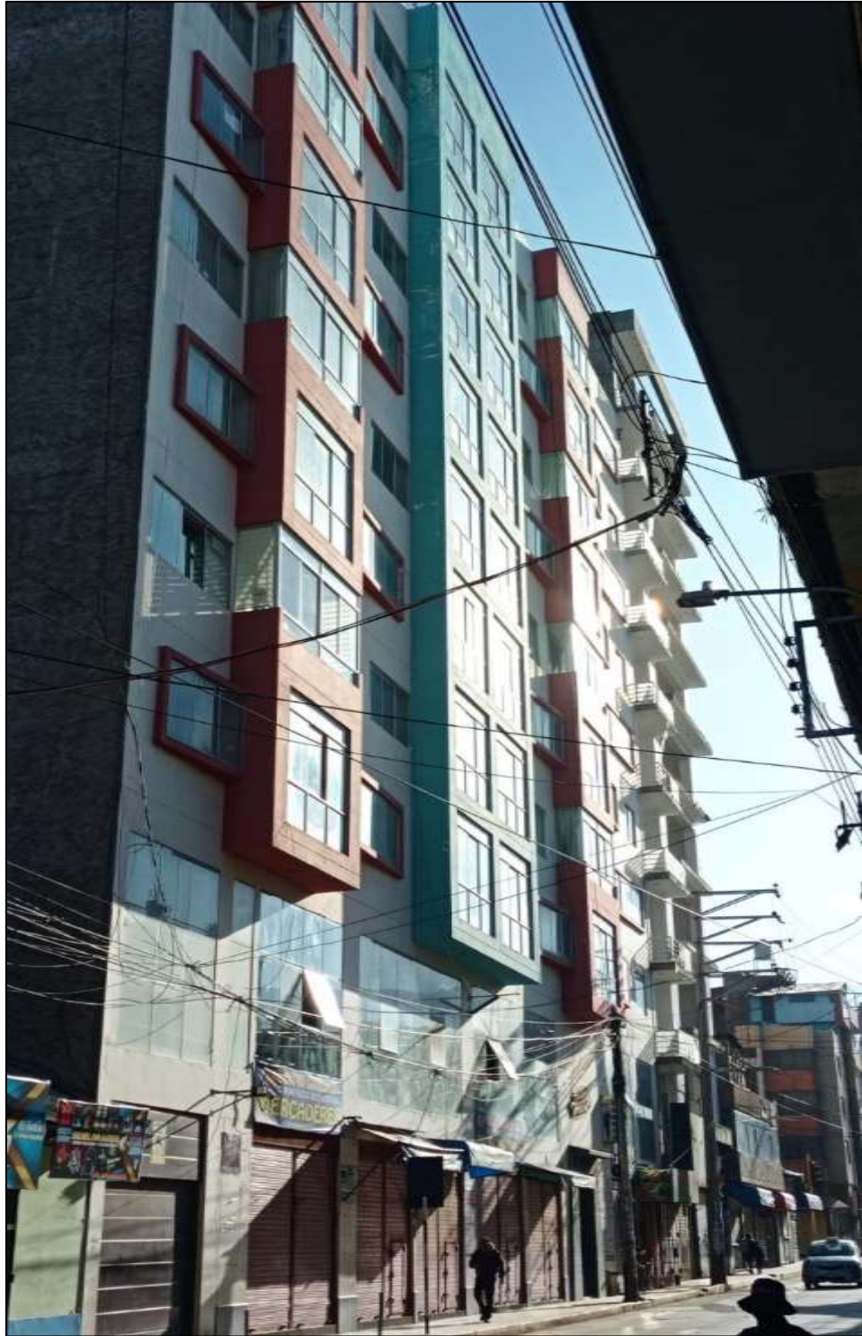
Fotografía N° 2. Vista frontal de la edificación
