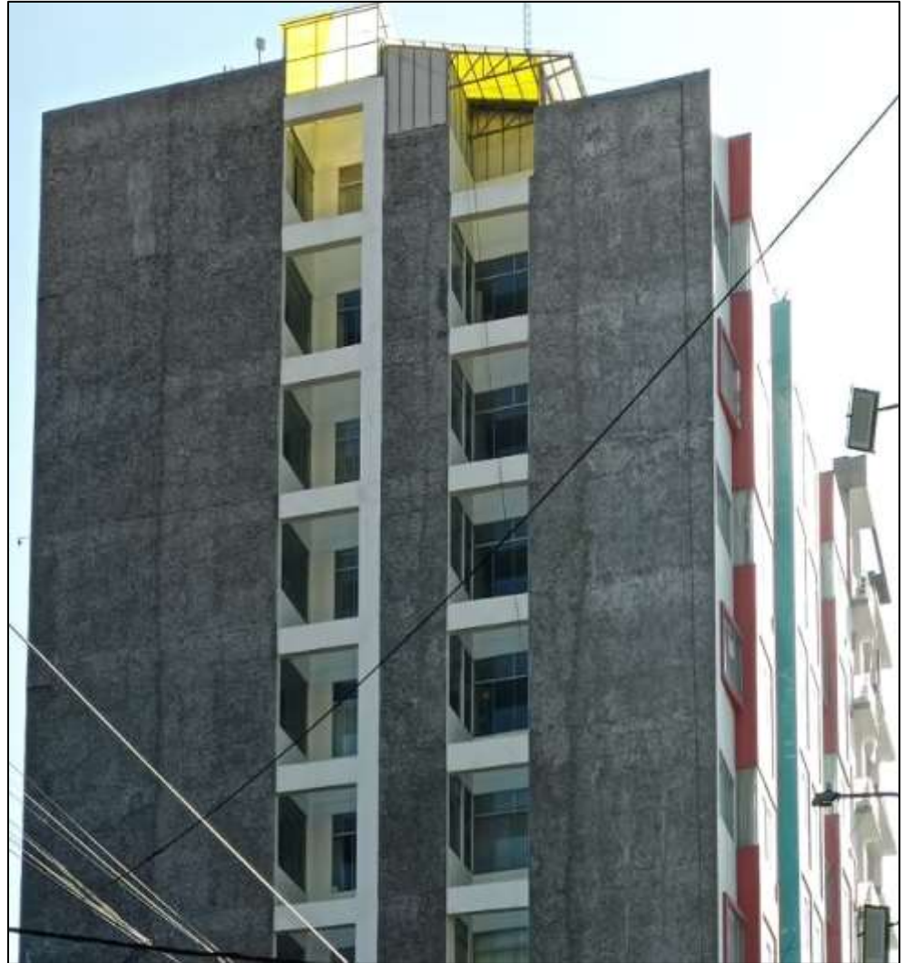
Figura N° 42. Tipo de Cubierta en la edificación.
