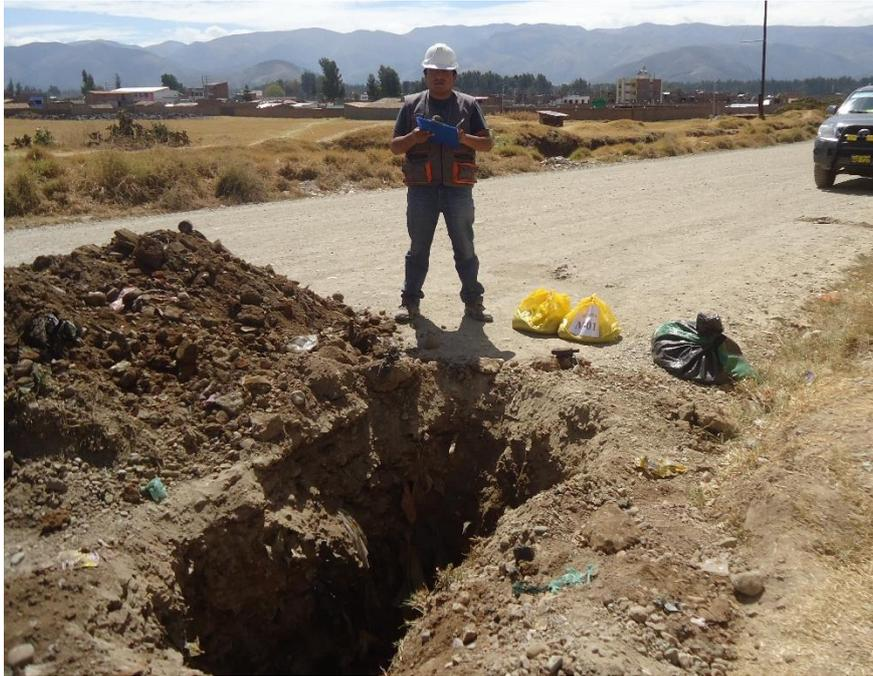
**Figura 04.** Excavación de la calicata 01 progresiva 0+162.50
