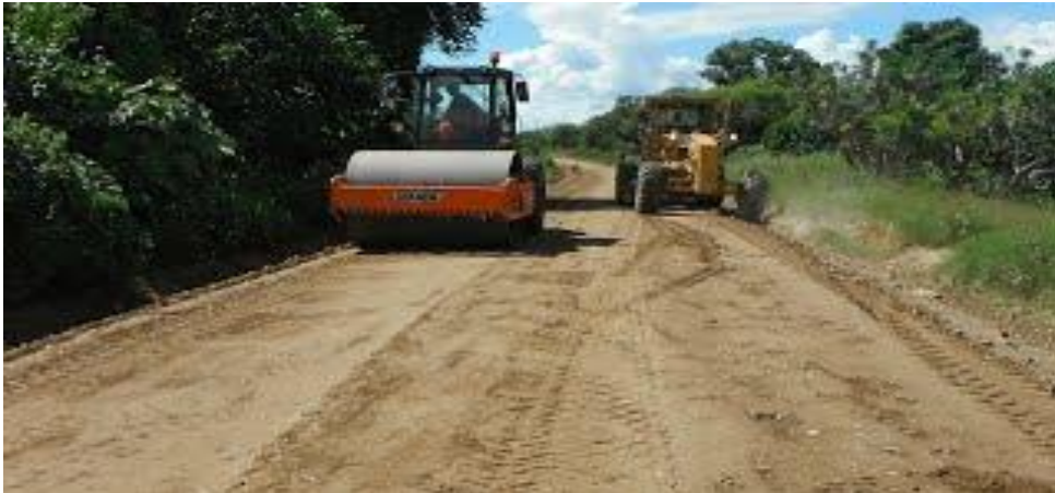
Figura N° 1: Afirmado de base en una carretera
