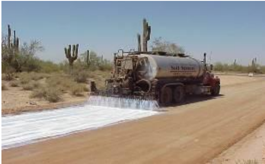
Figura Nº 6: Estabilización de vías sin asfaltar
