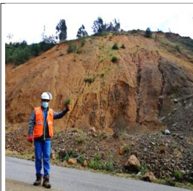
Foto 01: Vista panorámica de la cantera de afirmado km: 8+000
