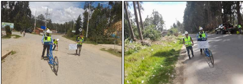
Fotografía 6. En las fotografías se observa la aplicación del método IRI en el tramo de estudio CARRETERA SANTA ROSA-CONCEPCION-JUNIN, kilometraje: 3+200, sentido DERECHO; kilometraje: 3+980, sentido IZQUIERDO.
