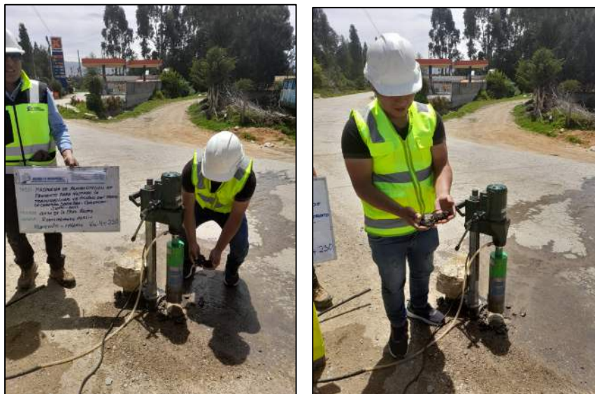
Fotografía 4. En las fotografías se observa la aplicación del método de extracción de corazones diamantinos en el tramo de estudio CARRETERA SANTA ROSA- CONCEPCION-JUNIN, kilometraje: 3+840.
