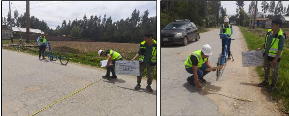
Fotografía 5. En las fotografías se observa la aplicación del método INDICE DE CONDICIÓN DELPAVIMENTO PCI en el tramo de estudio CARRETERA SANTA ROSA-CONCEPCION-JUNIN, kilometraje: 4+200.
