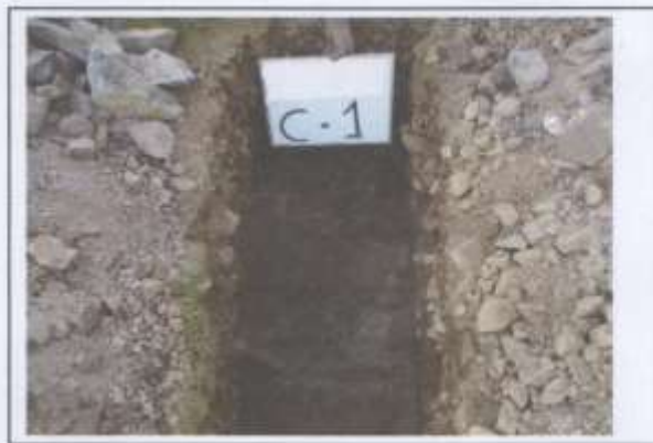
FOTO 02.- PERFIL ESTRATIGRAFICO, C-1, EDIFICIO DE DEPARTAMENTOS "LAS COLINAS DE CHALAY" – SAN JERONIMO DE TUNAN
