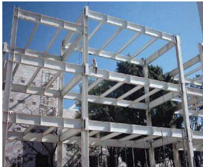
Figura 12 Pórticos con Estructura de Acero
