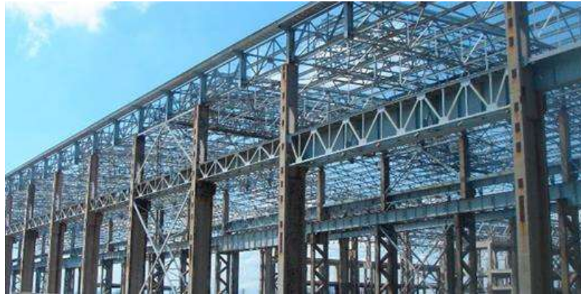
Figura 10 Estructura de Acero
