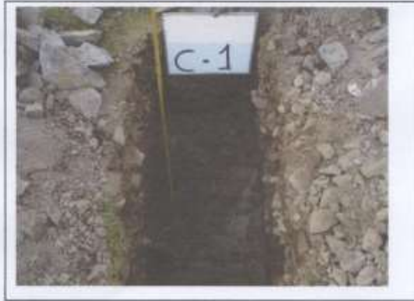
FOTO 03.- PROFUNDIDAD DE EXCAVACION, C-1, EDIFICIO DE DEPARTAMENTOS "LAS COLINAS DE CHALAY" – SAN JERONIMO DE TUNAN
