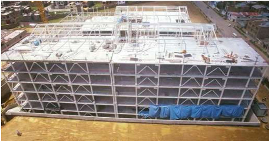
Figura 2 Vista del Módulo con Estructura Metálica Compuesta del Hospital El Carmen
