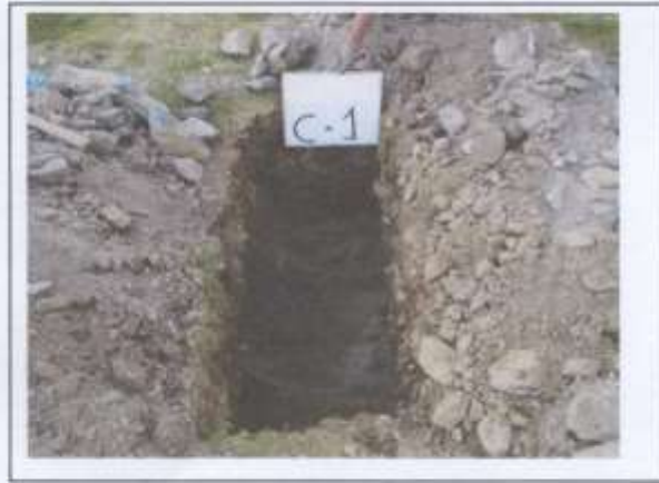
FOTO 01.- EXCAVACION DE LA CALICATA, C-1, EDIFICIO DE DEPARTAMENTOS "LAS COLINAS DE CHALAY" – SAN JERONIMO DE TUNAN
