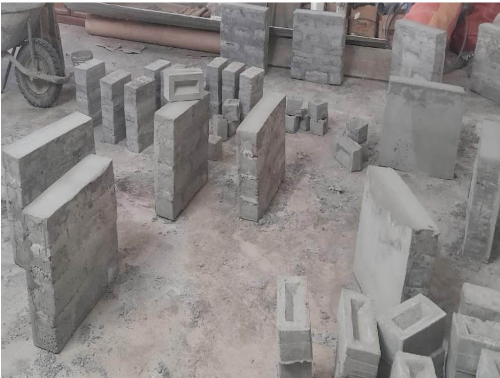
Fotografía 18. Elaboración de muros
