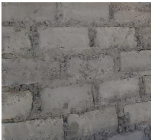
Figura 4.14. Muro con ladrillos de concreto.
