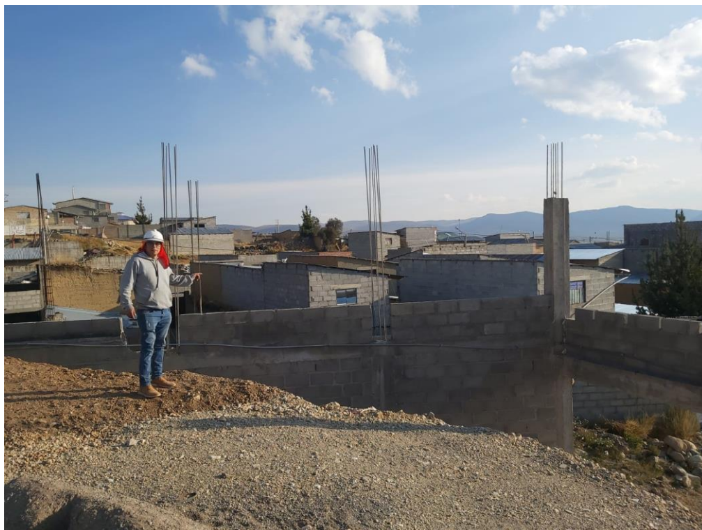
Fotografía 01. Viviendas con unidades de concreto.
