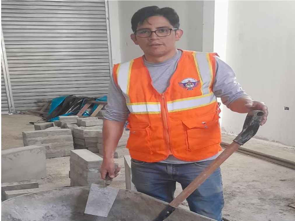
Fotografía 15. Elaboración de pilas con ladrillo de concreto y mortero
