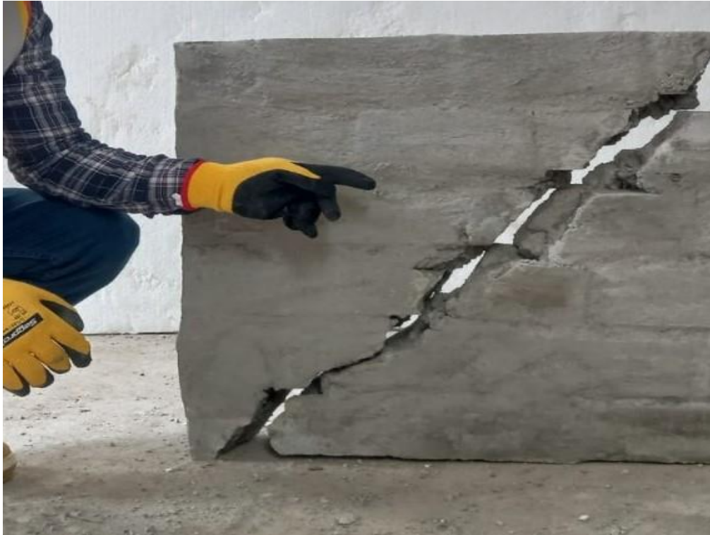
Fotografía 23. Falla por tracción diagonal
