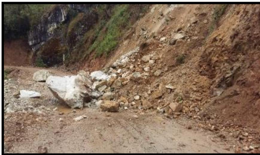
*Figura 28* Talud deslizado N° 2.
