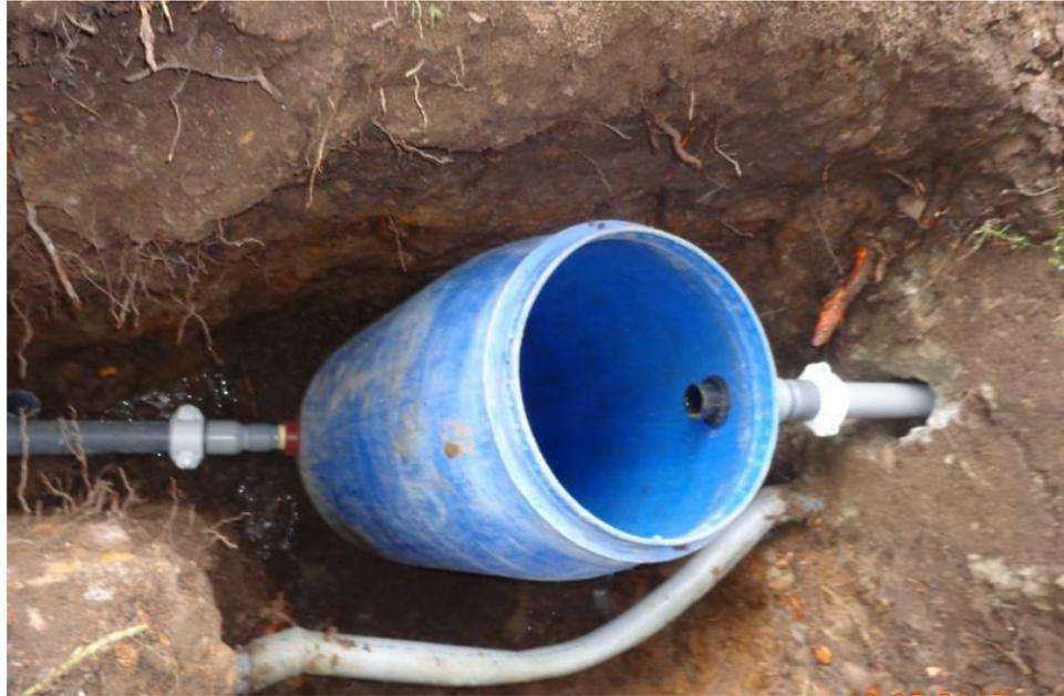
Figura 30 Instalación de los filtros de carbón activo granular
