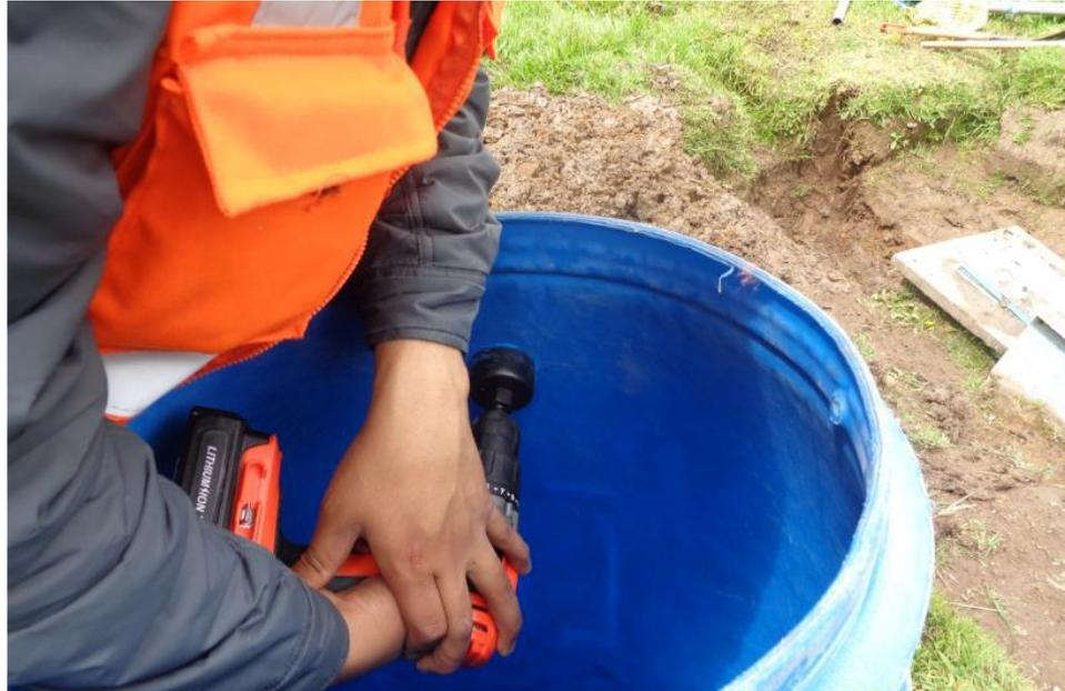
Figura 29 Construcción de los filtros de carbón activo granular
