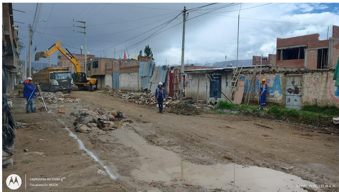
Fotografía 4. Partida de Trazo y Replanteo, Topógrafo y Operario en la nivelación de veredas.
