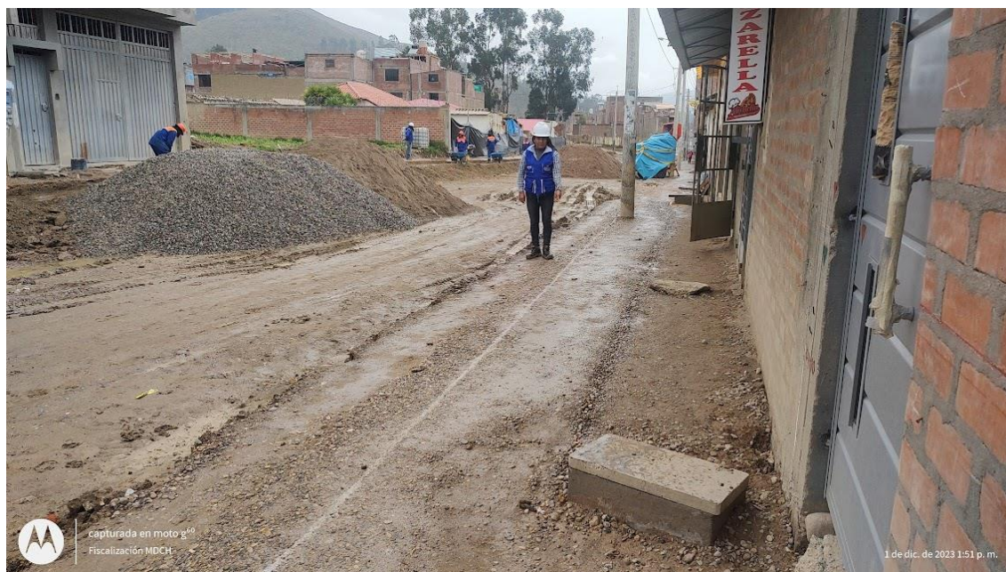
Fotografía 1. Partida de Trazo y Replanteo, haciendo uso de yeso, para excavaciones
