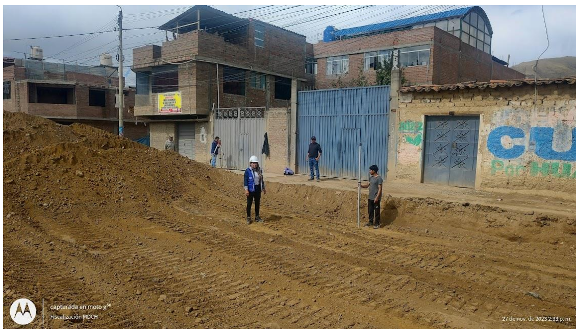
Fotografía 3. Partida de Trazo y Replanteo, Topógrafo y Operario en la nivelación de base de pavimento
