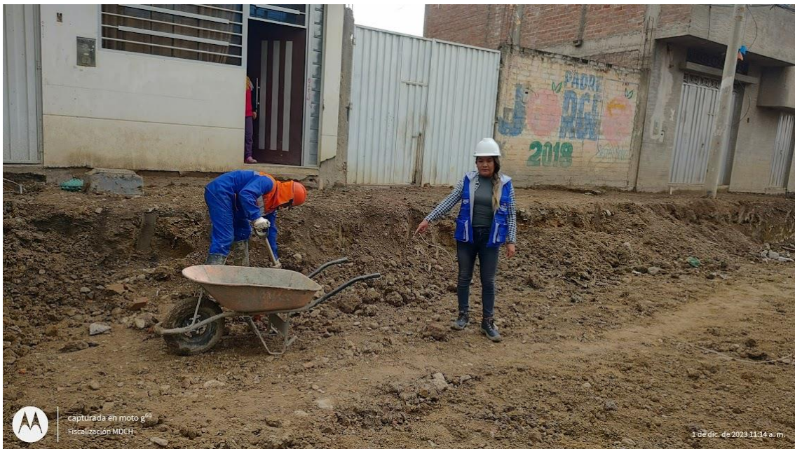
Fotografía 8. Partida Acarreo de Material Excedente, Peón transportando material a una distancia < a 30 m.
