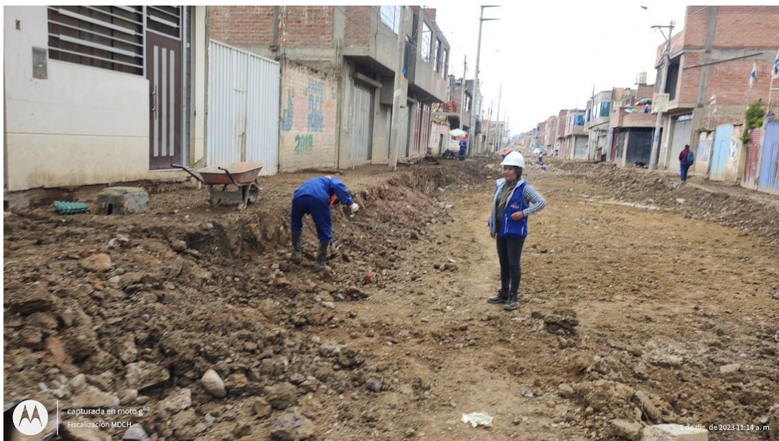
Fotografía 5. Partida Excavación Manual en Terreno Normal, Peón haciendo excavaciones para sardinel de veredas
