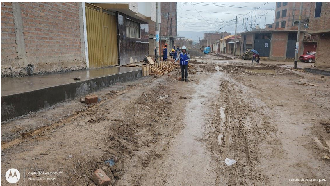
Fotografía 10. Partida Encofrado, Peones, armando estructura para encofrado de sardineles
