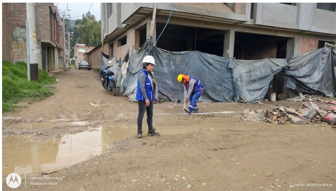
Fotografía 2. Partida de Trazo y Replanteo, Peón trazando con yeso
