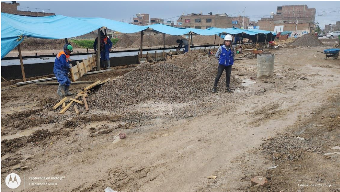
Fotografía 9. Partida Encofrado, Peones, armando estructura para encofrado
