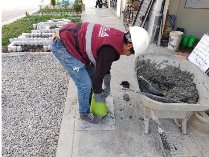
Fotografía N°08: Vista general del ensayo de asentamiento del concreto fast track (NTP 339.035).
