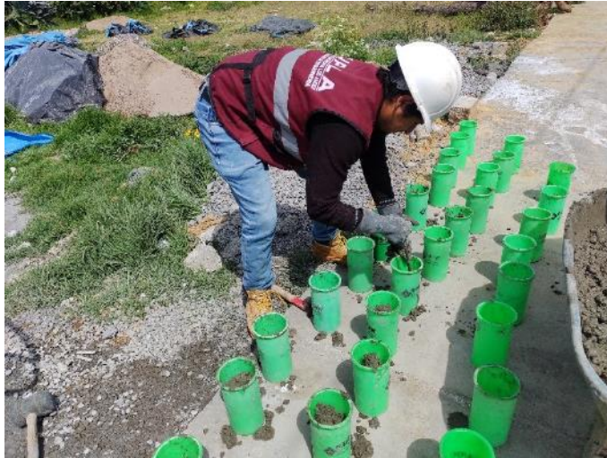
Fotografía N°14: Vista general del proceso de elaboración de testigos de concreto convencional.
