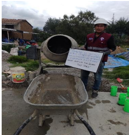
Fotografía N°09: Vista general del proceso de mezclado del concreto fast track.
