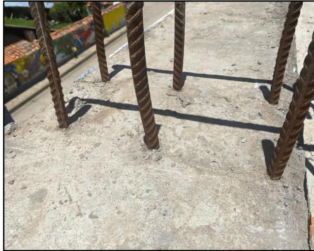
Figura 50 Vista de los aceros existente "C-2" (Fotografía N°8)
