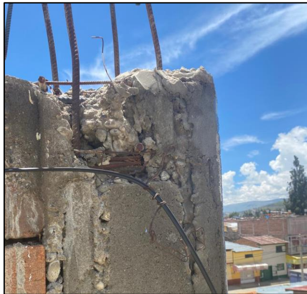
Figura 51 Vista de los aceros existente "C-1" (Fotografía N°9)
