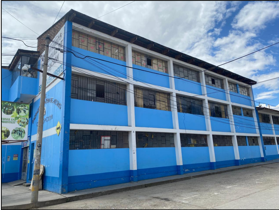
Figura 45 Bloque 1 existente - Vista 3D (Fotografía N°3)
