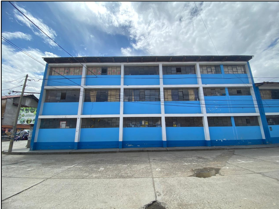
Figura 46 Bloque 1 existente - Vista Longitudinal (Fotografía N°4)
