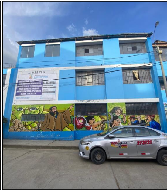
Figura 48 Bloque 2 existente (Fotografía N°6)
