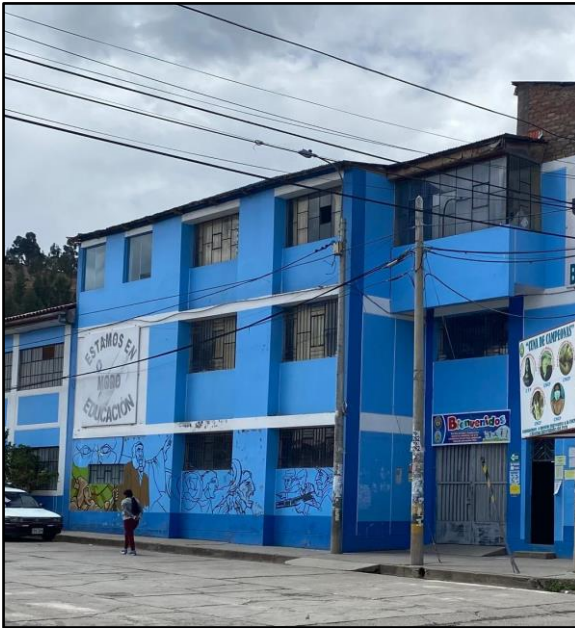
Figura 47 Bloque 2 existente (Fotografía N°5)
