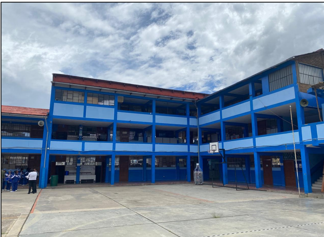
Figura 49 Vista Interior Bloque 1 y Bloque 2 – Existente (Fotografía N°7)
