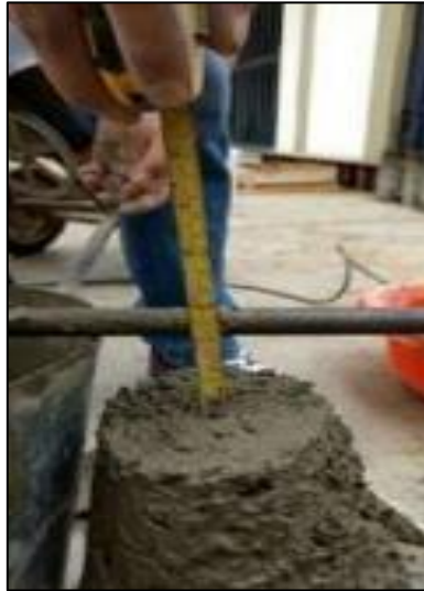
Figura 26: Ensayo de asentamiento
