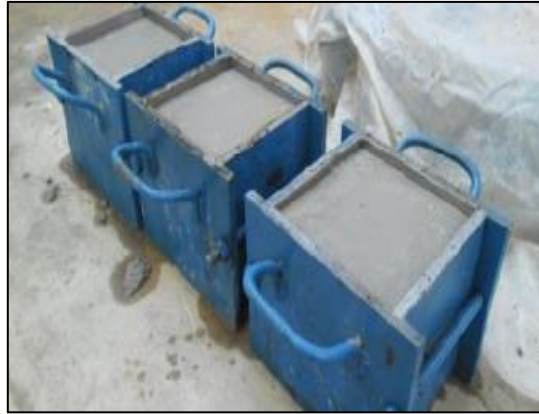
Figura 12: Recipientes llenos con mortero de hormigón.
