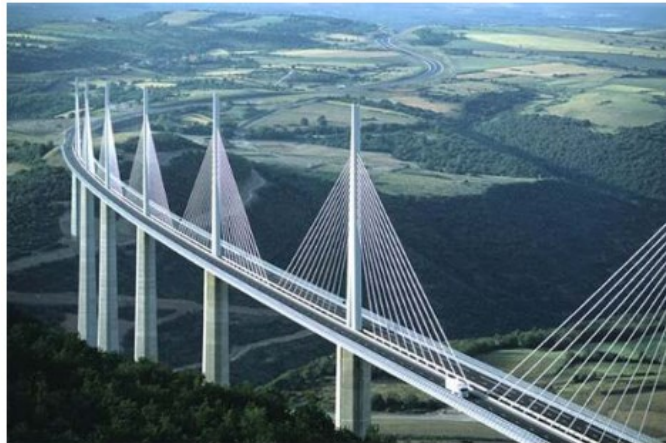
Figura 9- Estructura metálica colgante.
