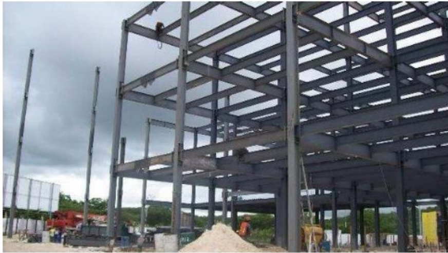
Figura 7- Estructura metálica entramada.
