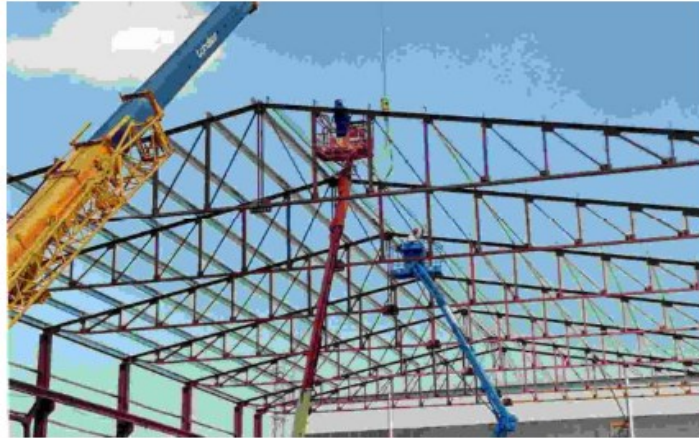
Figura 8- Estructura metálica triangulada.
