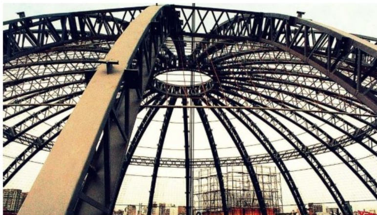
Figura 6- Estructura metálica abovedada.
