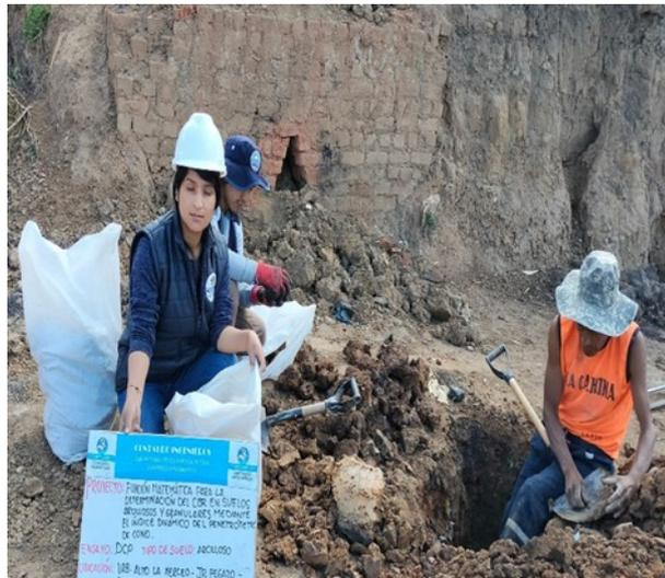
Fotografía 8. Excavación de calicata, toma de coordenadas y medida de estrato de material arcilloso - granular.
