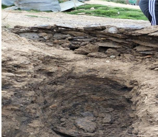
Fotografía 13. Calicata realizada en la vía para extraer material arcilloso.
