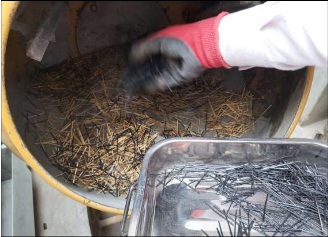
Figura 32. Vertido de fibra de tereftalato polietileno a máquina mezcladora.
