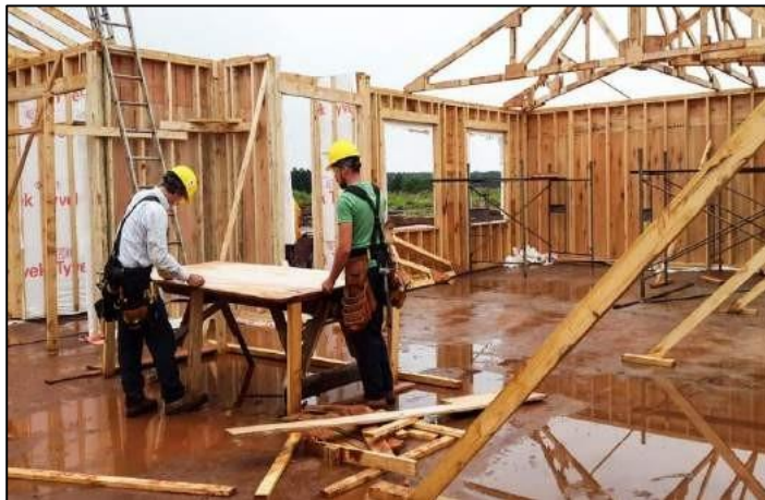
Figura 15: Sistema constructivo de madera
