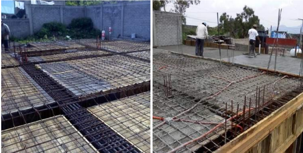
Figura 1: Gran cantidad de refuerzo de acero en losas de concreto
