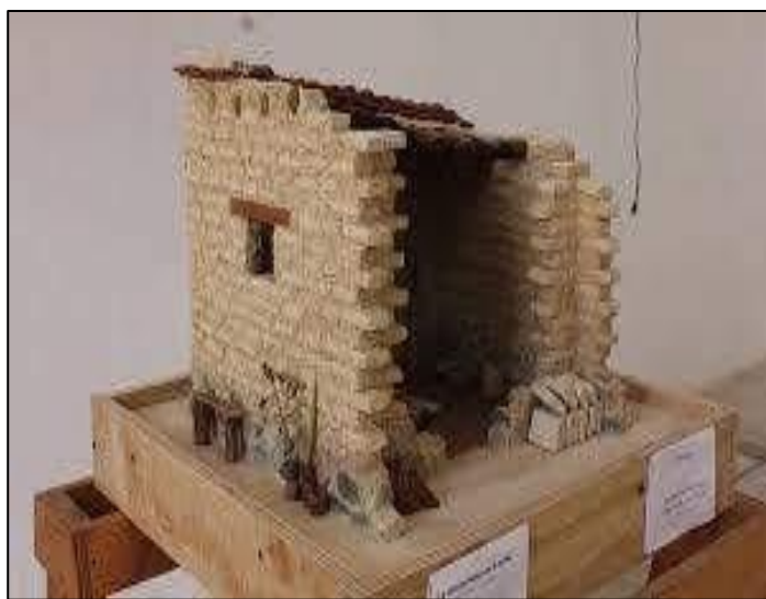
Figura 13: Sistema constructivo tradicional
