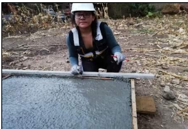
Fotografía N° 51: Temperatura del concreto usado para la elaboración de la losa aligerada para techo para su verificación de hidratación; según referencia de RNE E 060.
