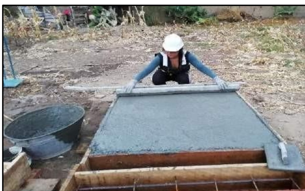
Fotografía N° 52: Uniformidad y enrasado de la losa para su posterior Fragua y endurecimiento del concreto; según referencia de RNE E 060.
