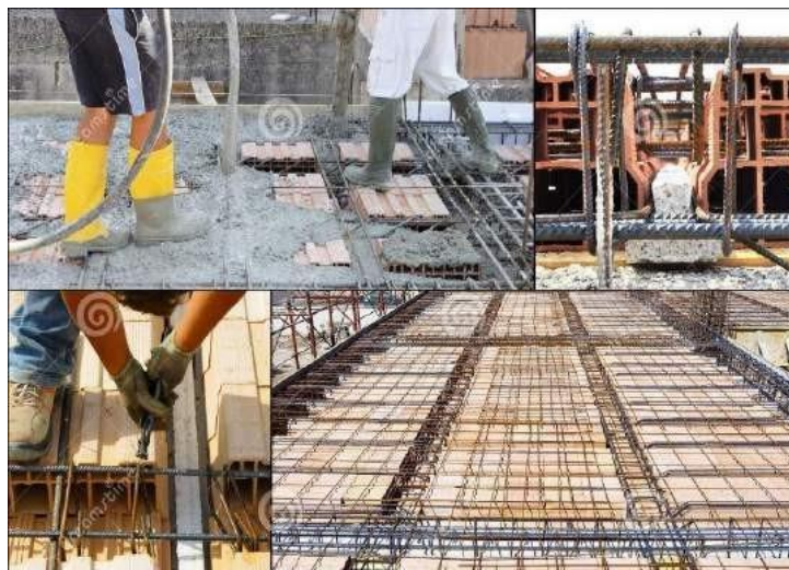
Figura 7: Aplicación del concreto
