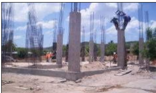
Figura 19: Columna en la construcción de un colegio
