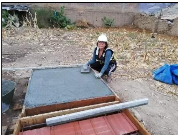
Fotografía N° 50: Acabado de la losa aligerada para techo de acuerdo a la medida y del peralte; dejando alineados y medidas simétricas; según referencia de RNE E 060.
