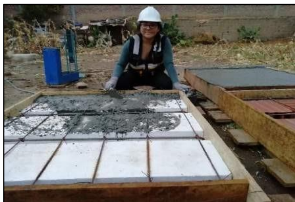
Fotografía N° 49: Colocación de los ladrillos de techo de acuerdo a la medida y del peralte; estas deben estar alineados y tener medida simétricas; según referencia de RNE E 060.
