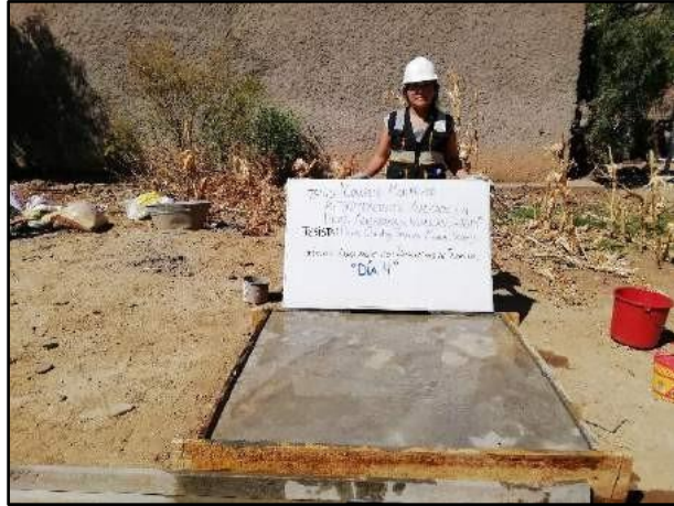
Fotografía N° 246: Para evitar su mal curado se debe evitar el resecamiento de las paredes de la losa en este tiempo; según referencia de la NTP 339.183.
