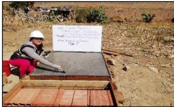
Fotografía N° 223: Cubrimiento después del acabado, para evitar la evaporación de agua del concreto sin endurecimiento de la losa, según referencia de la NTP 339.183.
