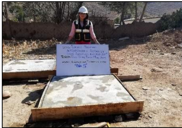
Fotografía N° 57: Día quinto del fraguado, el proceso es el mismo durante las fechas de ensayo endurecido como compresión y flexión, según referencia de la NTP 339.183.
