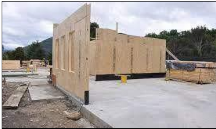
Figura 14: Sistema constructivo de paneles constructivos
