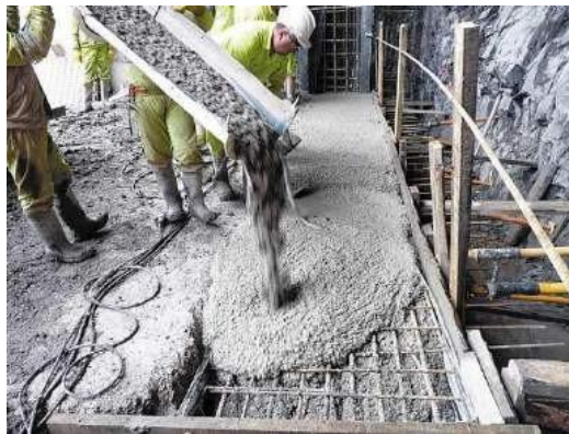
Figura 2: Cangrejeras en columnas y placas de edificaciones
