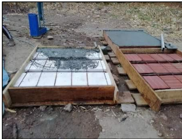
Fotografía N° 48: Elaboración de simulación de losas aligeradas, según RNE E 060.
