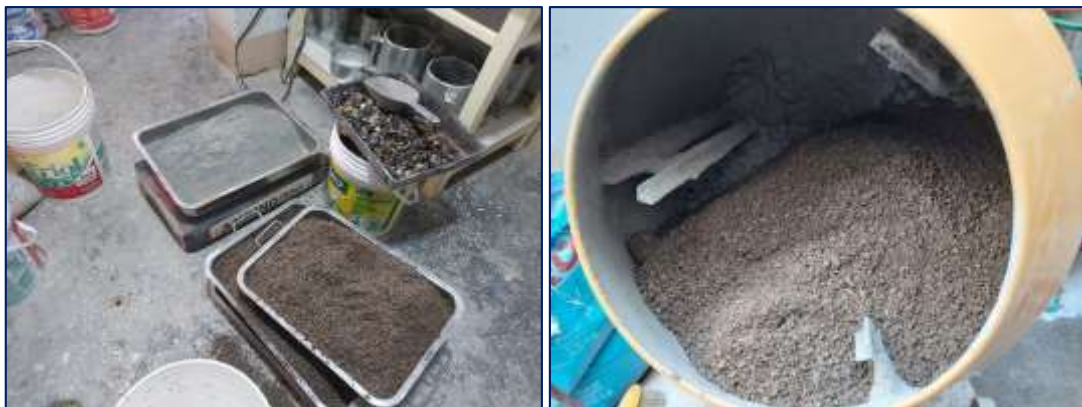
Fotografía 25. Vista de materiales y la elaboración del concreto con 100 % de escoria de piedra.
