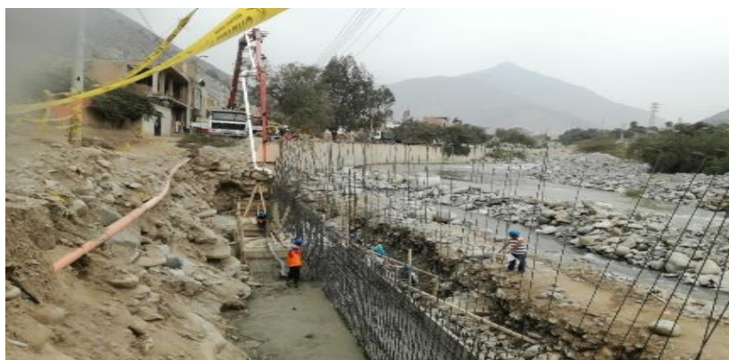
Figura N°07: construcción de un muro de contención
