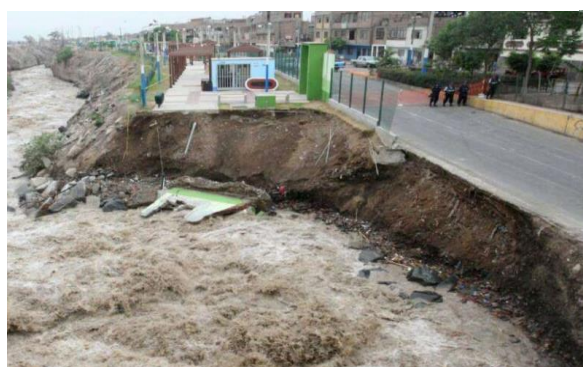
Figura N°02: Rio Rímac llevándose la vía del tren.
