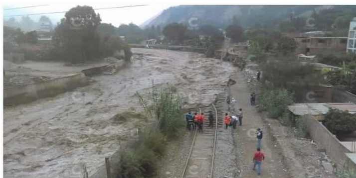
Figura N°06: Destrucción de rieles del ferrocarril.
