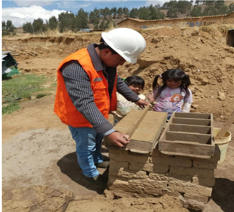
Fotografía N° 11: “Enraizado de la mezcla de arcilla”.
