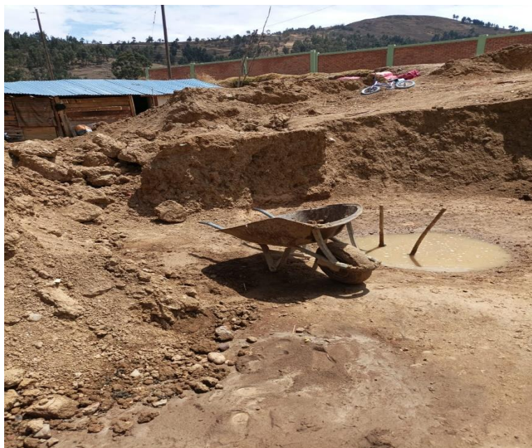
Fotografía N° 02: “Selección de material para la elaboración de ladrillos de arcilla”.
