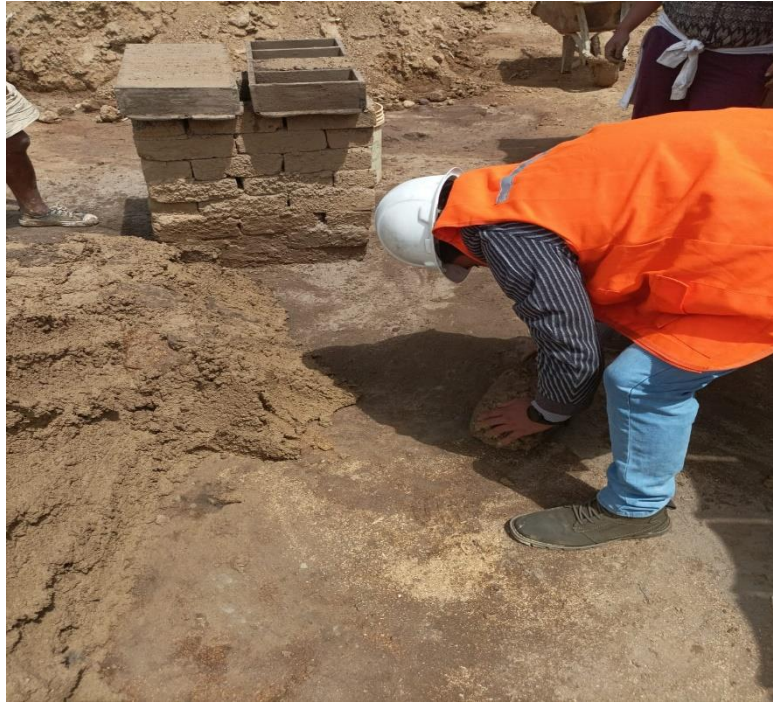
Fotografía N° 9: “Mezcla del polietileno, con la mezcla de arcilla”.
