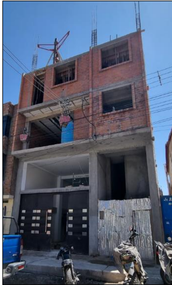
Vista exterior de la obra
