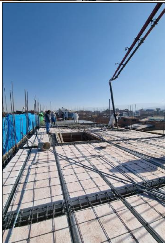
Viguetas prefabricadas de acero en el techo del segundo nivel
