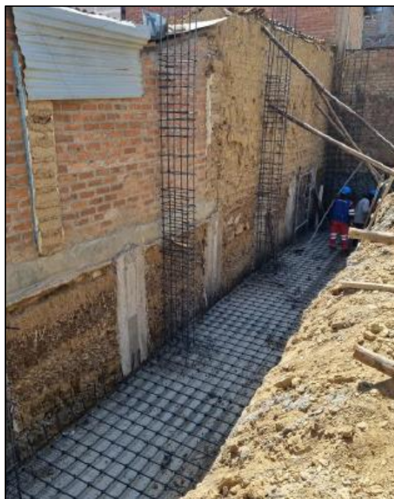
Izado de columnas
