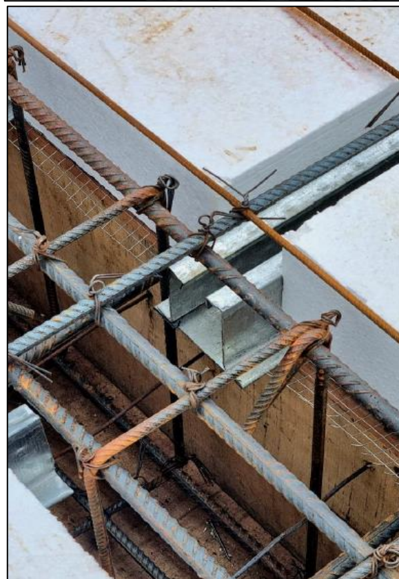
Vigueta apoyada viga interior
