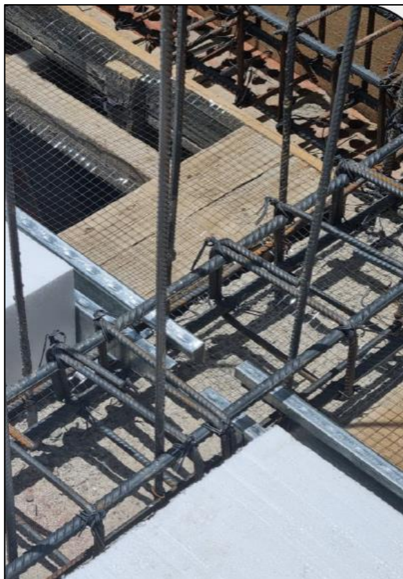
Vigueta apoyada en viga chata
