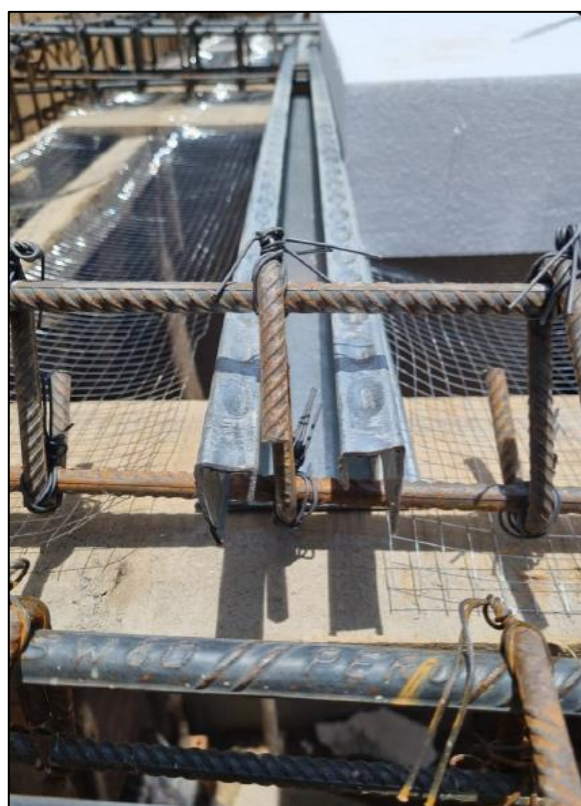
Vigueta en viga de borde
