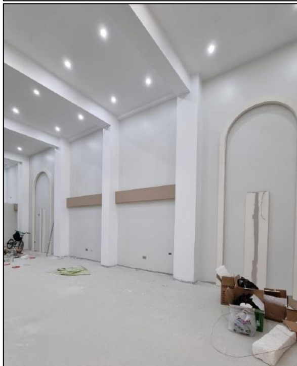
Pinturas y pisos – Primer nivel
