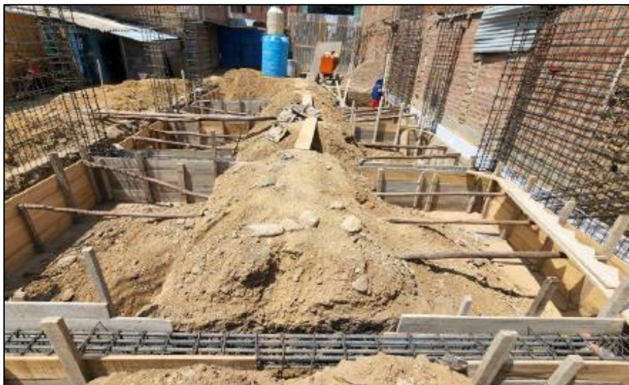
Habilitado de acero y encofrado de vigas de conexión
