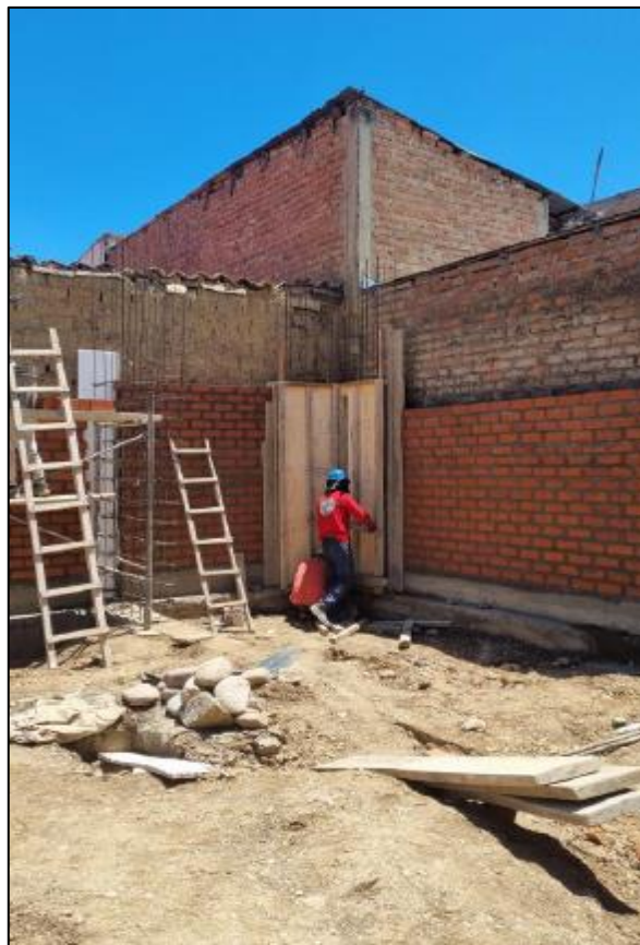
Muros de albañilería y vaciado de columnas y placas
