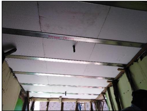
Figura 23. Viguetas prefabricadas colocadas
