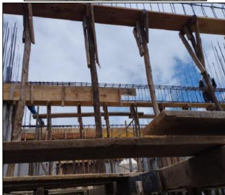
Encofrado de vigas para techos de primer nivel a doble altura
