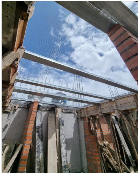
Viguetas prefabricadas en techo de segundo nivel
