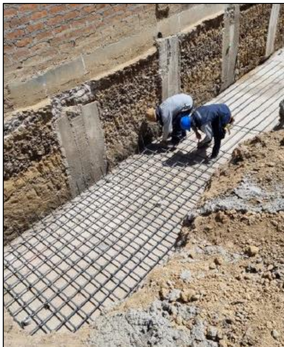
Vaciado de solado y armado de malla inferior de zapatas
