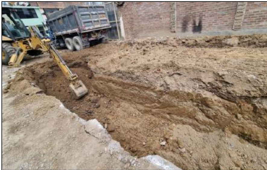
Trazo, replanteo y excavación de cimentaciones
