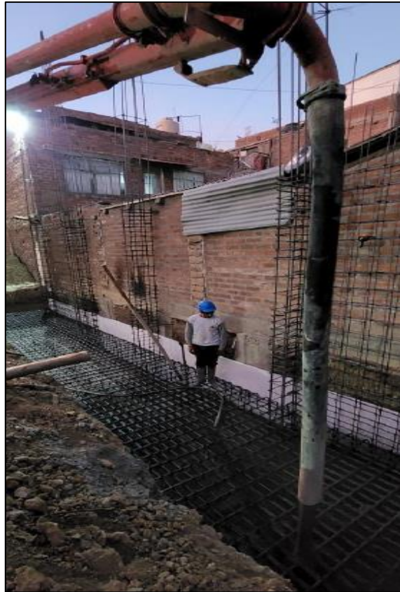
Vaciado de concreto en cimentación
