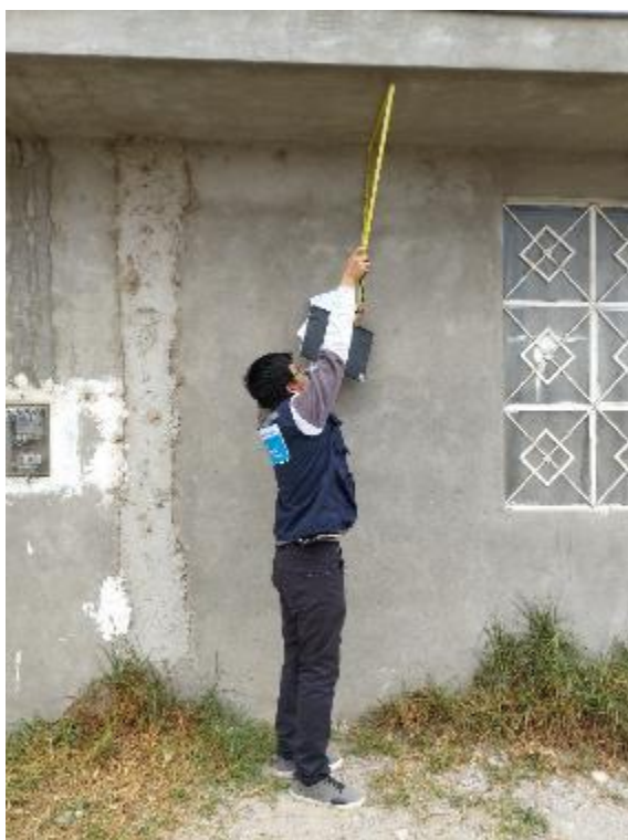
Fotografía 2: Tomando medidas del voladizo de la edificación
