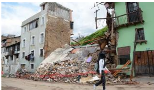
Figura 1.1: Colapso de Viviendas por terremoto
