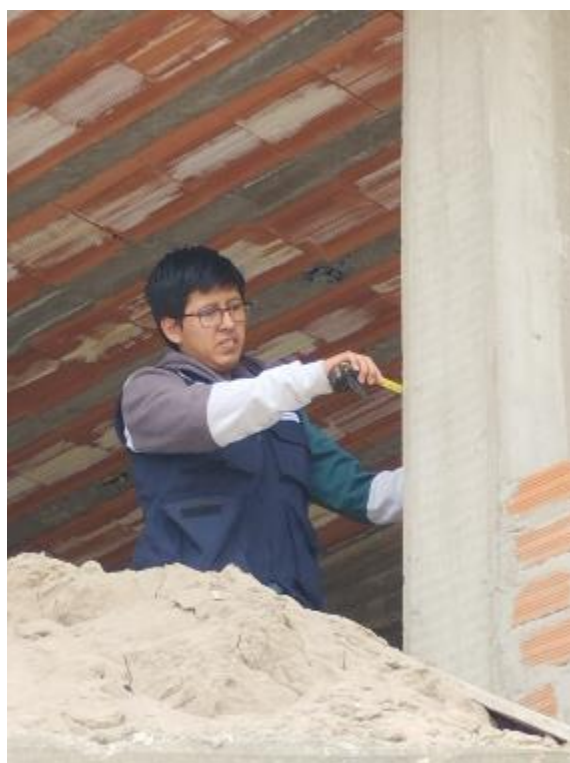
Fotografía 6: Tomando medidas de columna de viviendas
