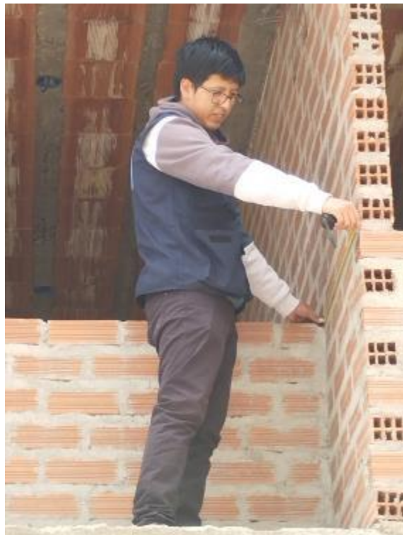
Fotografía 8: Tomando medidas de muros de viviendas
