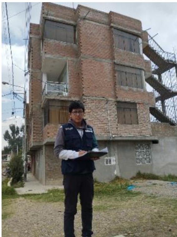
Fotografía 1: Vivienda con ladrillos pandereta en pisos 2, 3 y 4
