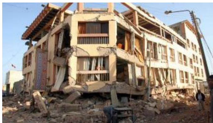
Figura 1.2: Edificación destruida durante el terremoto de Pisco
