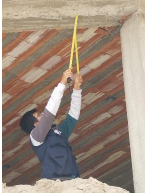
Fotografía 7: Tomando medidas de vigas de viviendas
