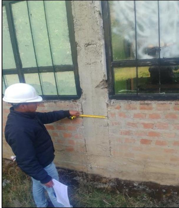
Fotografía 3. I.E. Santiago Antúnez de Mayolo – inspección técnica visual de columnas
