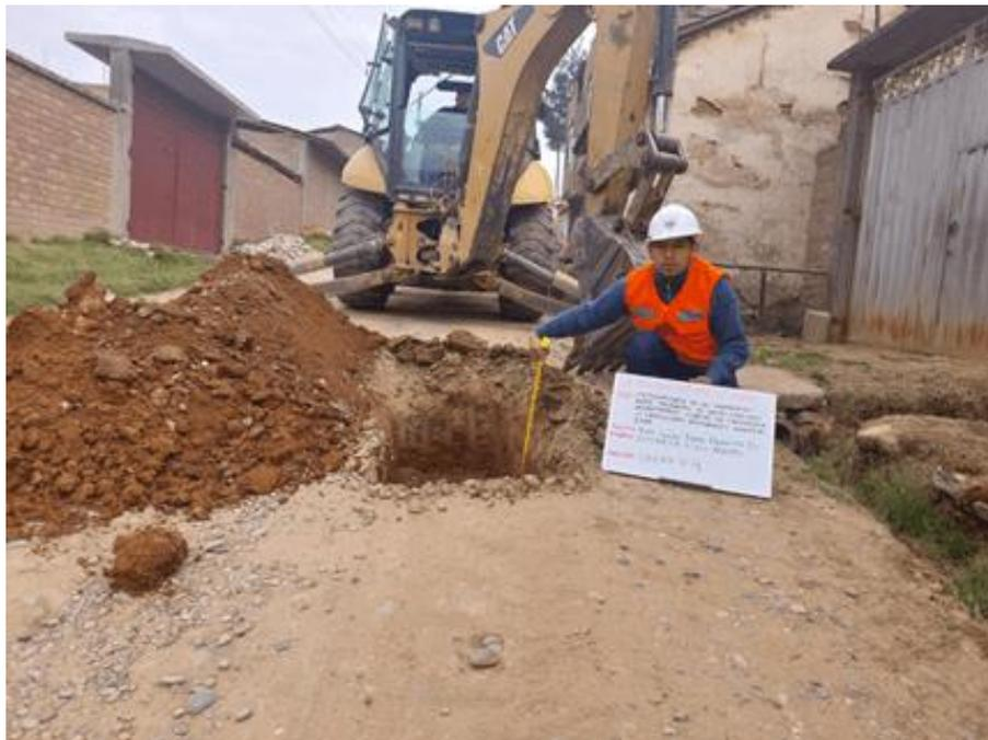
*Nota:* Excavación de suelo en la sección de subrasante c-1. Fuente: *Elaboración propia.*
