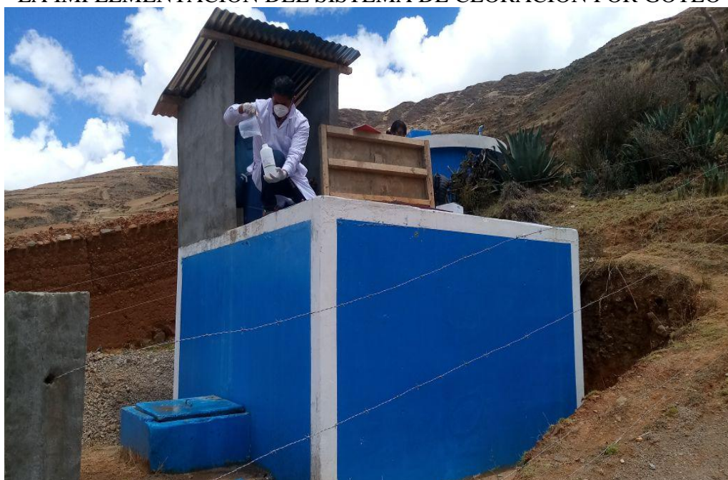
FOTO N° 04: EL PERSONAL DEL LABORATORIO, CASANDO LAS MUESTRAS PARA LLEVAR AL LABORATORIO, A LA VEZ SE VE EL AVANCE DE LA CASETA DEL SISTEMA DE CLORACION POR GOTEO
