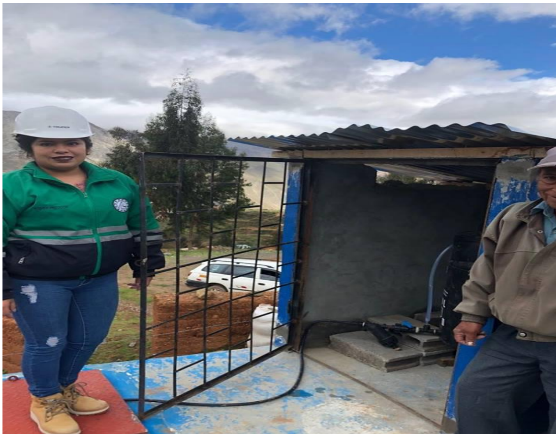
FOTO N° 09: COLOCANDO EL SISTEMA DE CLORACION POR GOTEO COMO EL TANQUE Y LOS DISPOSITIVOS
