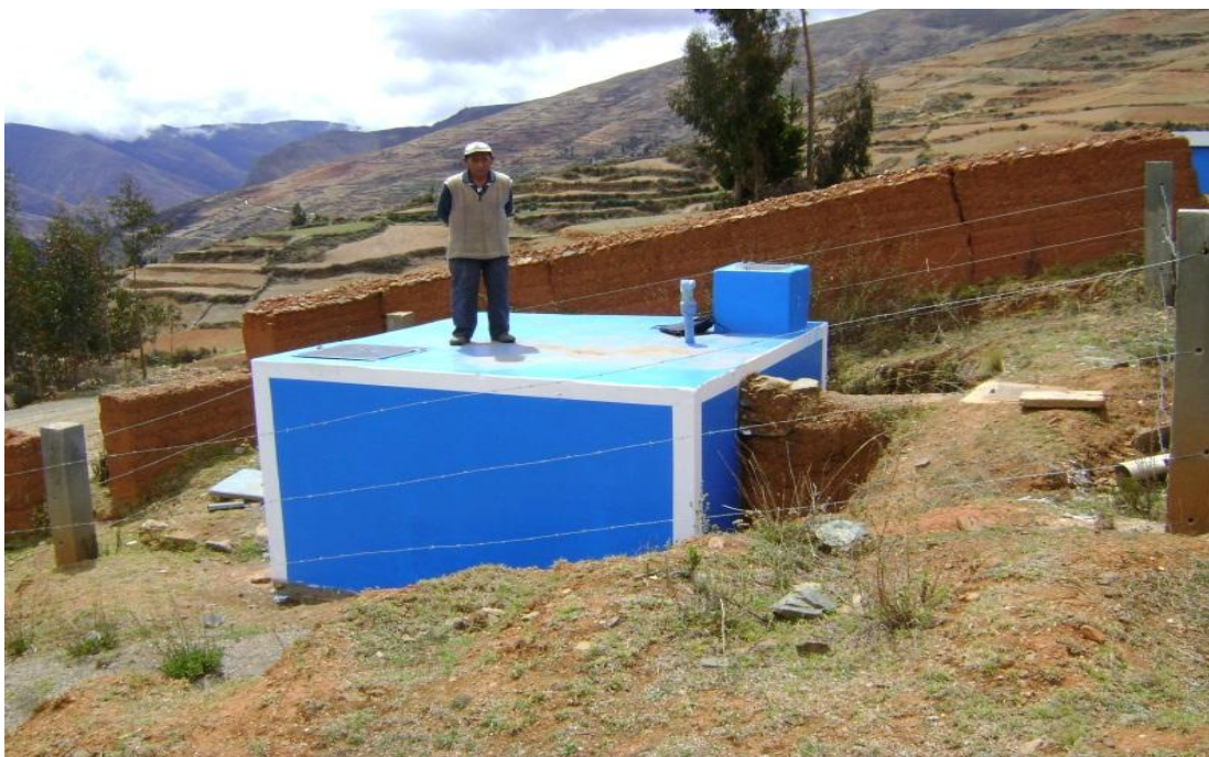
FOTO N° 01: ANTES DE REALIZAR LA IMPLEMENTACION DEL SISTEMA DE CLORACION
