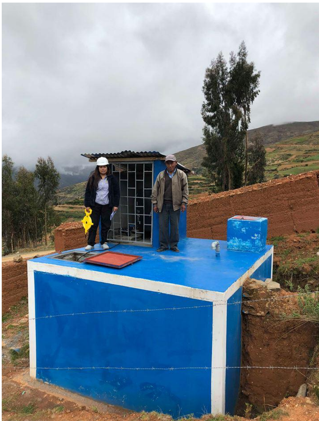
FOTO N° 13: CULMINACION DEL PROYECTO, DEJANDO UN SISTEMA DE AGUA SOSTENIBLE PARA LA POBLACION DE OCHONGACOA
