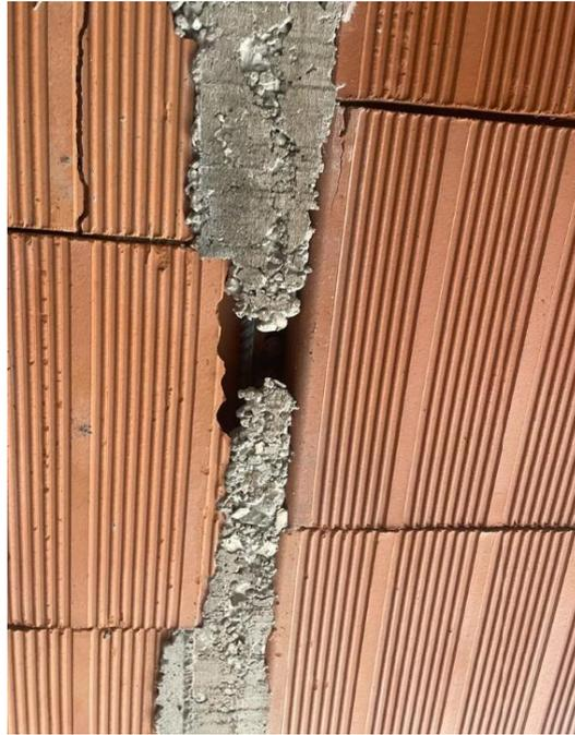
SE OBSERVA EN PARTE DE LA VIGUETA EL ACERO EXPUESTO Y SIN RECUBRIMIENTO DE CONCRETO
