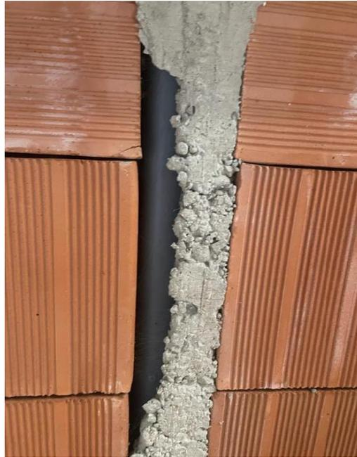
APRECIAMOS LA TUBERIA DE 2" SIN RECUBRIMIENTO Y EXPUESTA EN LA VIGUETA DE LA LOZA ALIGERADA
