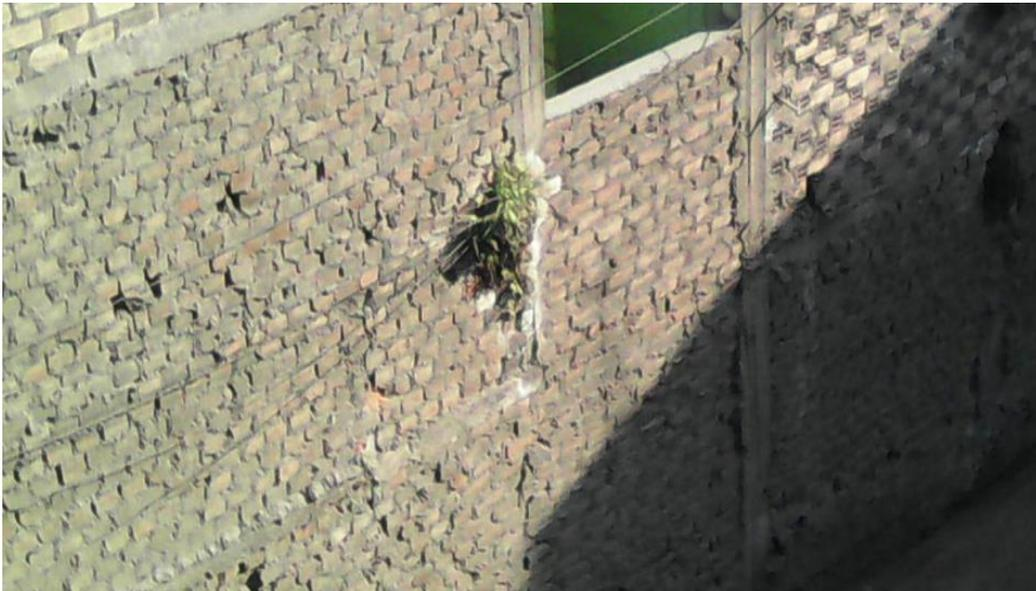
SE APRECIA EL MURO DE ALBAÑILERIA DE TIPO CABEZA CON UN PROCESO CONSTRUCTIVO DEFICIENTE
