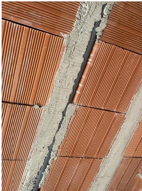
SE APRECIA EN TUBO DE SESAGUE CON UNA INSTALACION NO ADECUADA A FALTA DE PLANOS Y PARTE TECNICA
