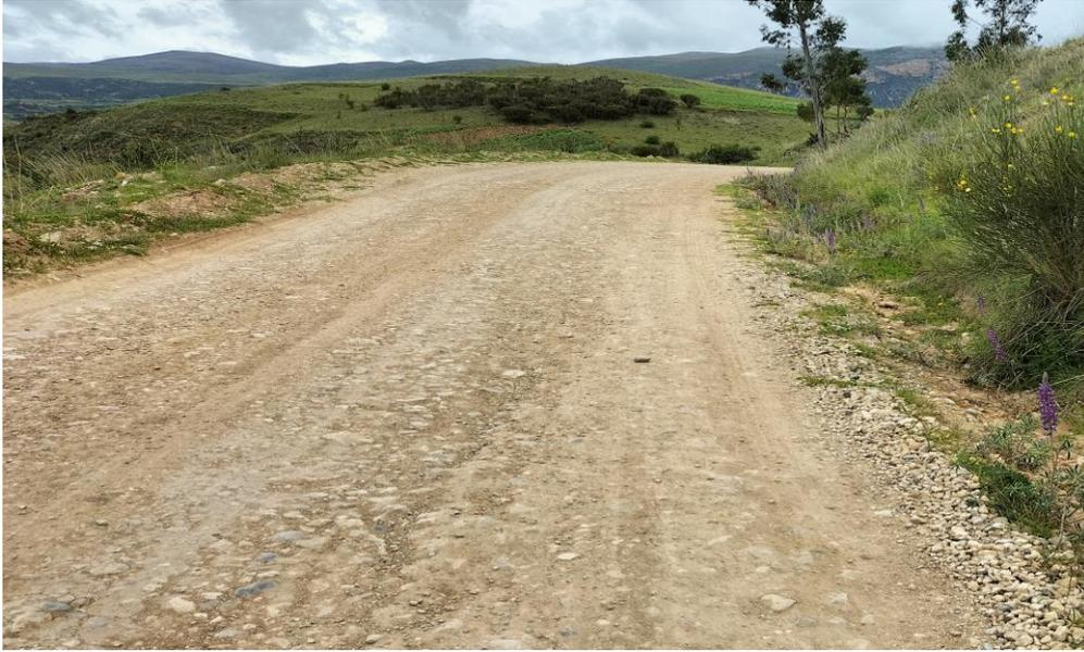
**Nota:** La superficie de rodadura es a nivel de Afirmado en este sector y se encuentra en regulares condiciones de transitabilidad, existiendo daños como erosiones.
