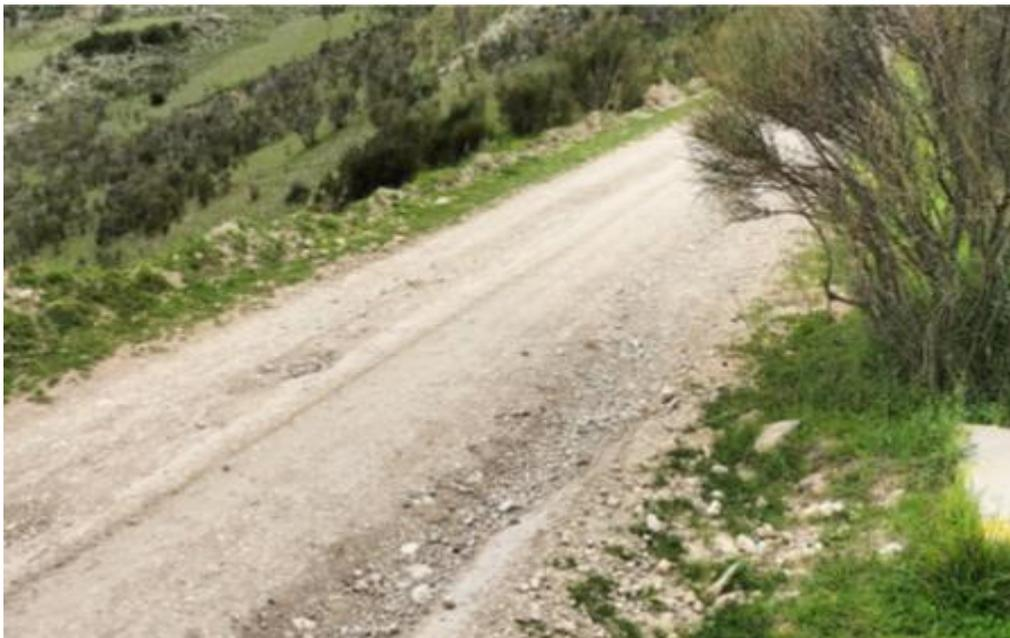
**Nota:** La superficie de rodadura es a nivel de Afirmado en este sector y se observa la existencia de baches.
