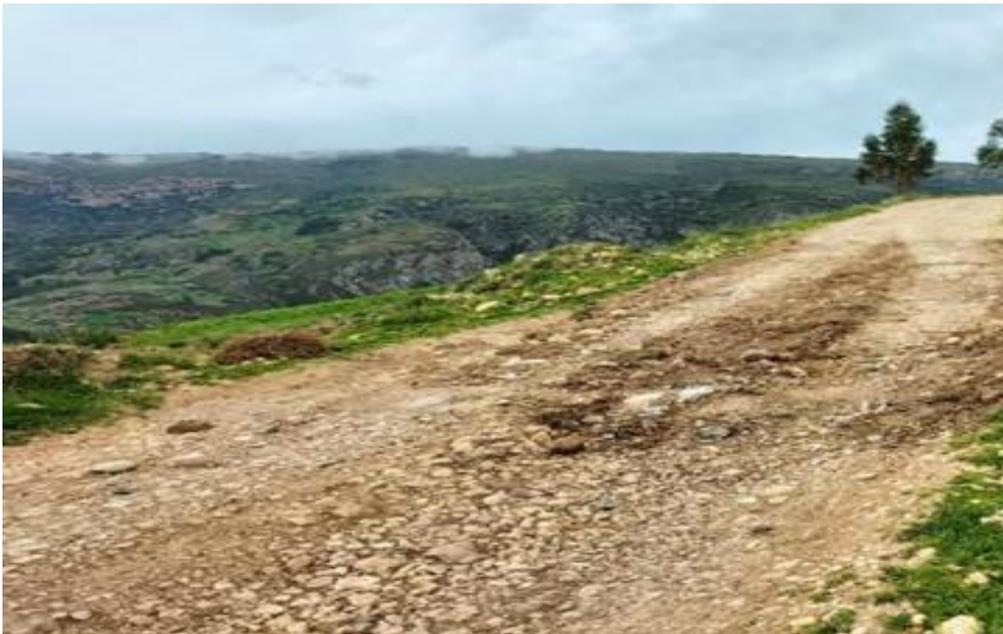
**Nota:** La superficie de rodadura es a nivel de Afirmado en este sector y se encuentra en pésimas condiciones de transitabilidad, debido a que ya se perdió el afirmado de la superficie de rodadura.
