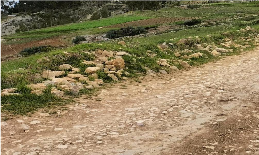
**Nota:** La superficie de rodadura es a nivel de Afirmado en este sector y se encuentra en pésimas condiciones de transitabilidad, debido a que ya se perdió el afirmado de la superficie de rodadura.
