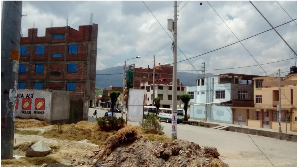
Gráfico 51. Vista de la intersección de la Av. Daniel Alcides Carrión y la futura vía expresa.
