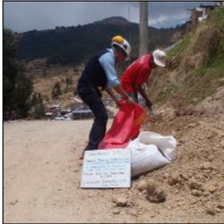
Fotografía 3: En la fotografía se observa el inicio de la excavación de la CALICATA No. 02 con coordenadas: E – 18 L 479757.940, N: 8666650.92, Z: 3414.
