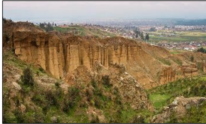
Figura 3: Taludes de Torre Torre.
