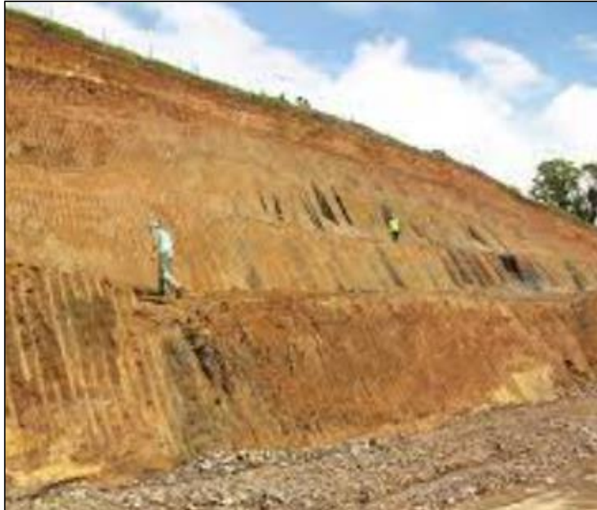
Figura 11: Talud de corte.
