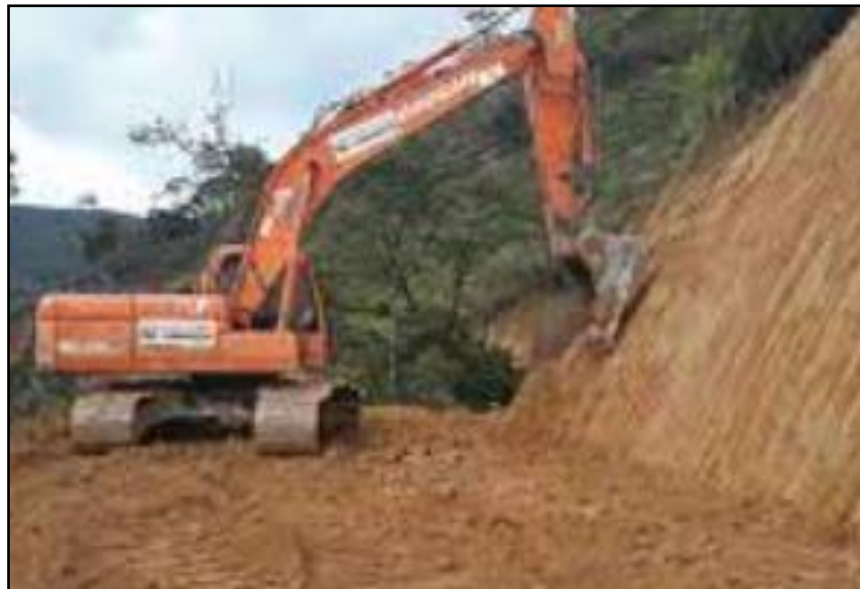
Figura 10: Corte de talud.
