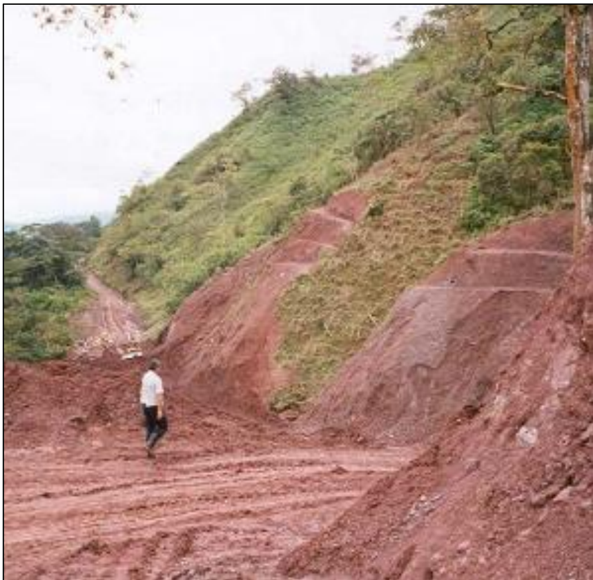
Figura 12: Talud de relleno.
