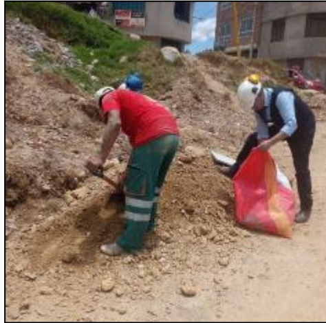
Fotografía 1: En la fotografía se observa el inicio de la excavación de la CALICATA No. 01 con coordenadas: E – 18 L 479655.705, N: 8666607.44, Z: 3427.
