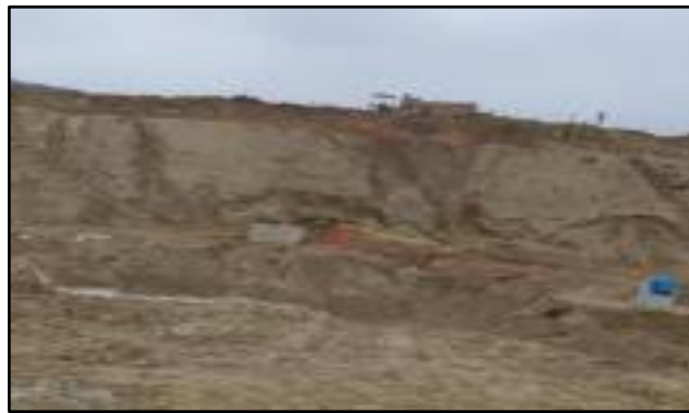
Figura 2: Taludes de Piura Perú.
