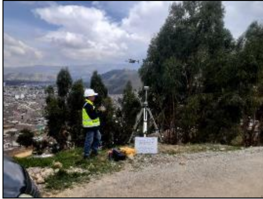
Fotografía 5: En la fotografía se observa el inicio del levantamiento topográfico, tramo: 0 + 000.
