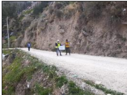
Fotografía 6: En la fotografía se observa el levantamiento topográfico del tramo: 0 + 400
