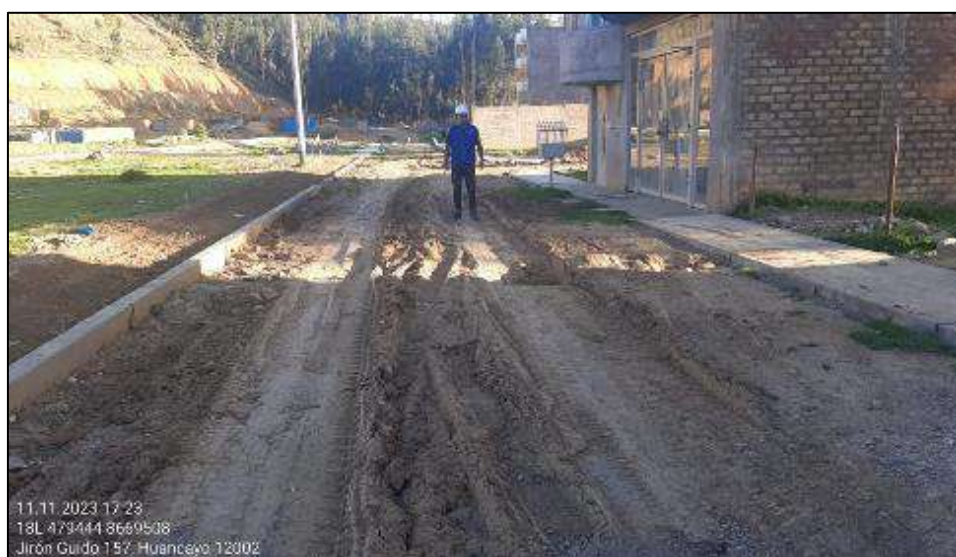
Figura 1.5. Inestabilidad de suelos arcillosos en una vía sin pavimentar Fuente: Elaboración propia
