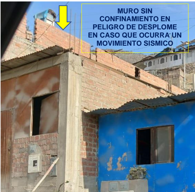
VIVIENDA EN PROCESO DE CONSTRUCCION
