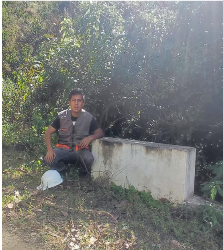
Figura N° 02: Reconocimiento de campo a pie, vista de alcantarilla que desfoga el caudal en terreno de cultivo
