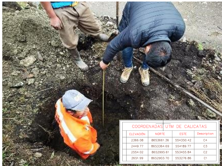
Figura N° 08: Excavación de calicata C2
