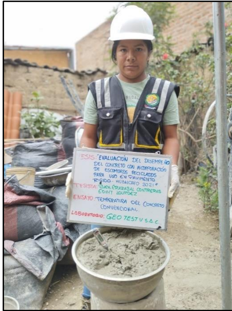
Fotografía 15: Medición de la temperatura del concreto saliendo de la mezcladora convencional, según referencia de la norma NTP 339.184.
