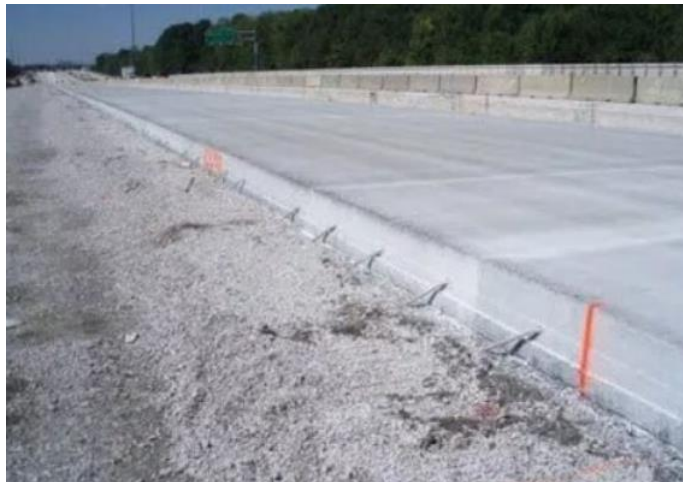
Figura 17. Construcción de carreteras con hormigón de alto rendimiento
