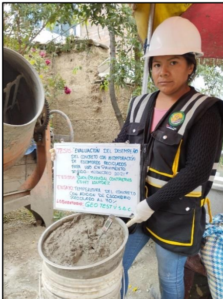
Fotografía 48: Medición de la temperatura del concreto saliendo de la mezcladora con adición del con adición del 70% de escombro reciclado, según referencia de la norma NTP 339.184.
