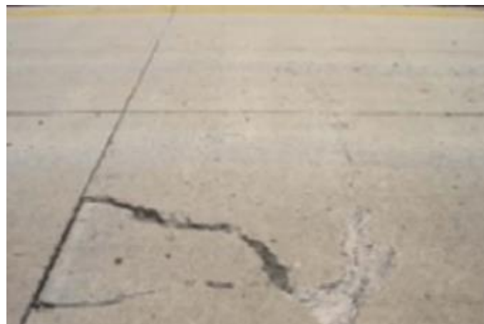
Figura 23. Agrietamiento
