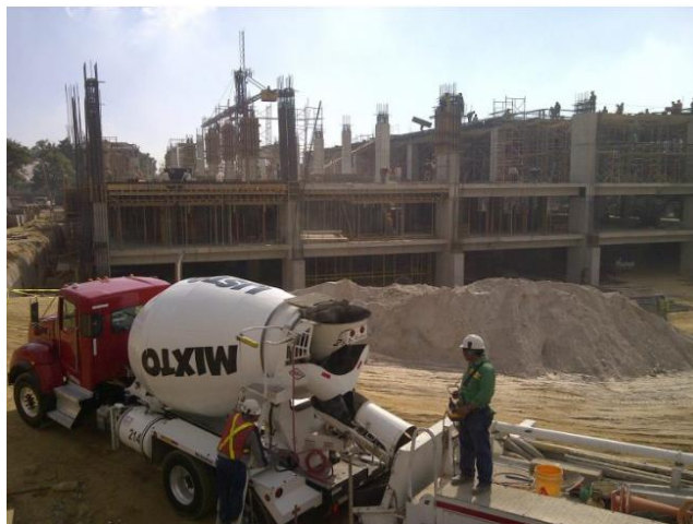
Figura 11. Desempeño del concreto
