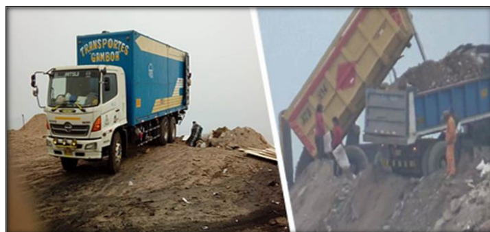
Figura 2. Residuos de construcción.
