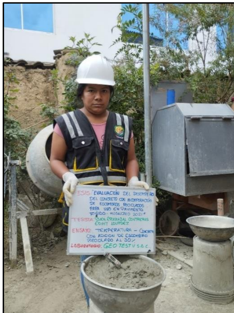
Fotografía 26: Medición de la temperatura del concreto saliendo de la mezcladora con 30% de escombro reciclado, según referencia de la norma NTP 339.184.
