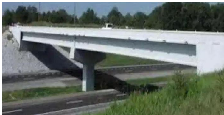
Figura 16. Concreto de alto rendimiento utilizado en la construcción de sobrevuelos
