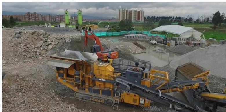
Figura 1. Reciclaje de concreto (Bogotá).
