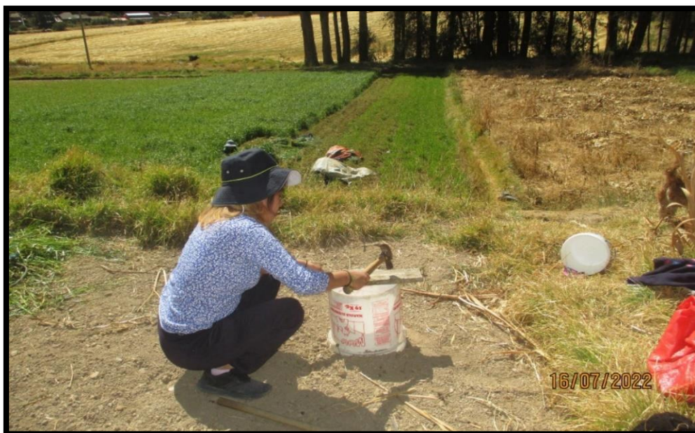
Fotografía 5. : Nivelando el cilindro en la superficie
