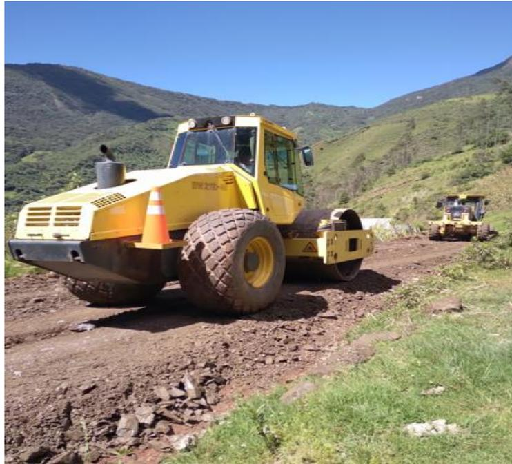
fotografía N°9: se observa el compactado de material de cantera en la plataforma de la vía del proyecto
