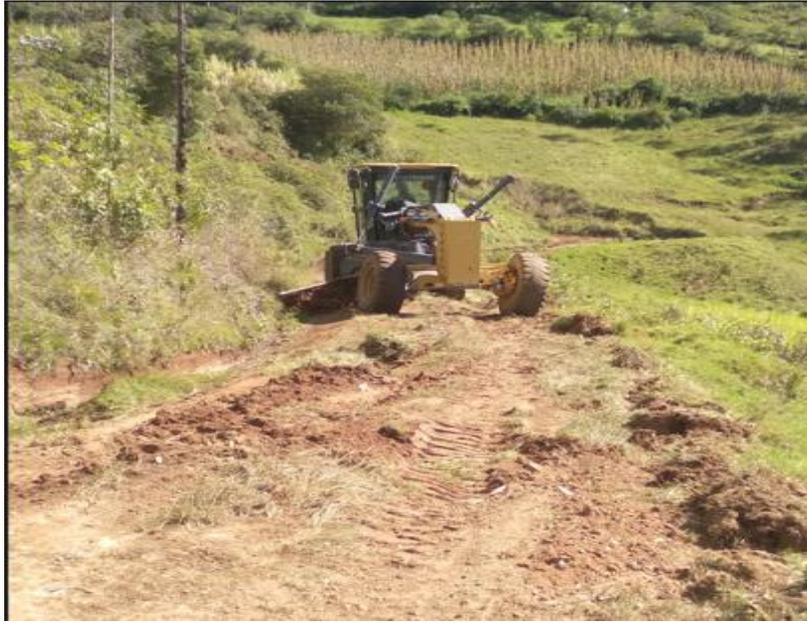
Fotografía N°11: se observa la conformación de cuneta planteado en el trabajo de suficiencia.
