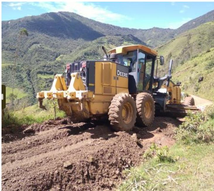
Fotografía N°10: se observa el extendido de material de cantera en la plataforma de la vía del proyecto planteado
