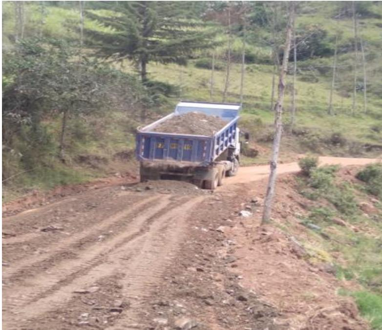
Fotografía N°7: se observa el colocado de material de cantera en el tramo del proyecto
