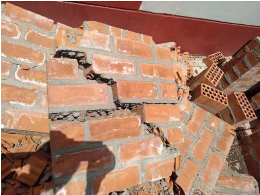
Fotografía 44. Luego de los ensayos, se hace evidente la falla por corte en los muretes.
