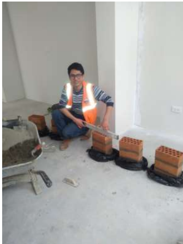
Fotografía 26. Comprobación de la calidad de los prismas.
