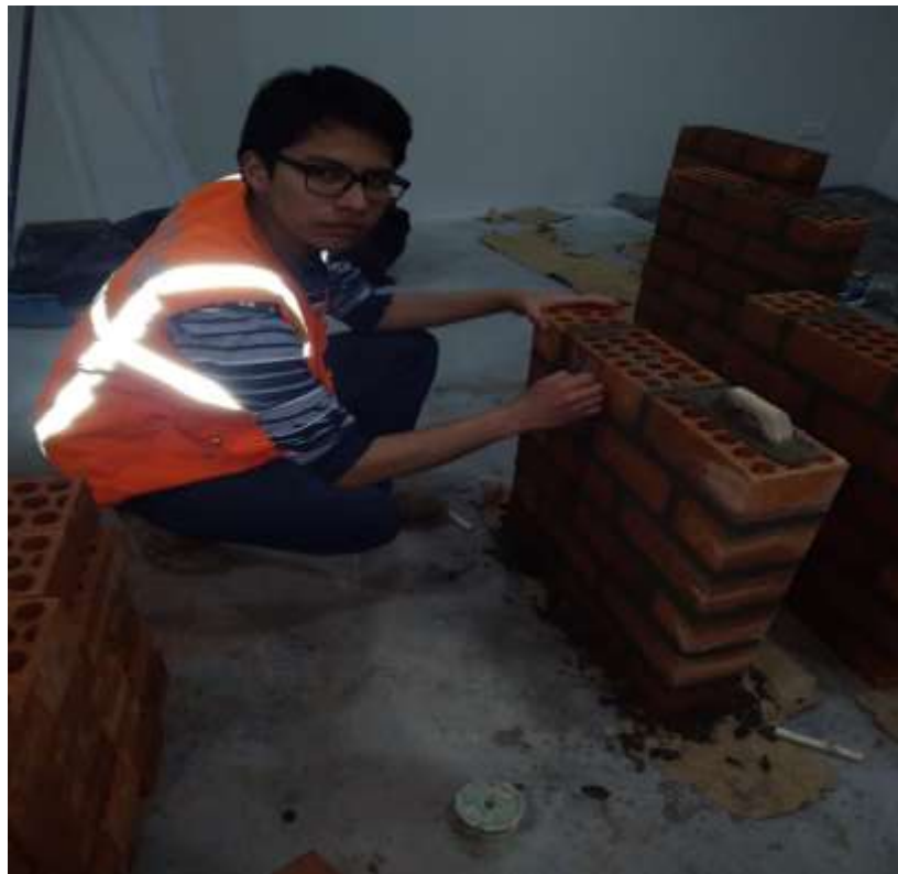
Fotografía 24. Marcado de los muretes de albañilería.
