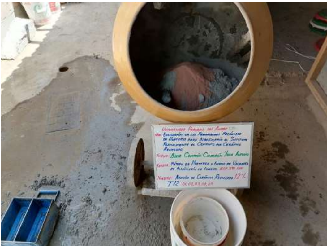
Fotografía 22. Mezclado del mortero con 12 % de sustitución del cemento por cerámico reciclado.
