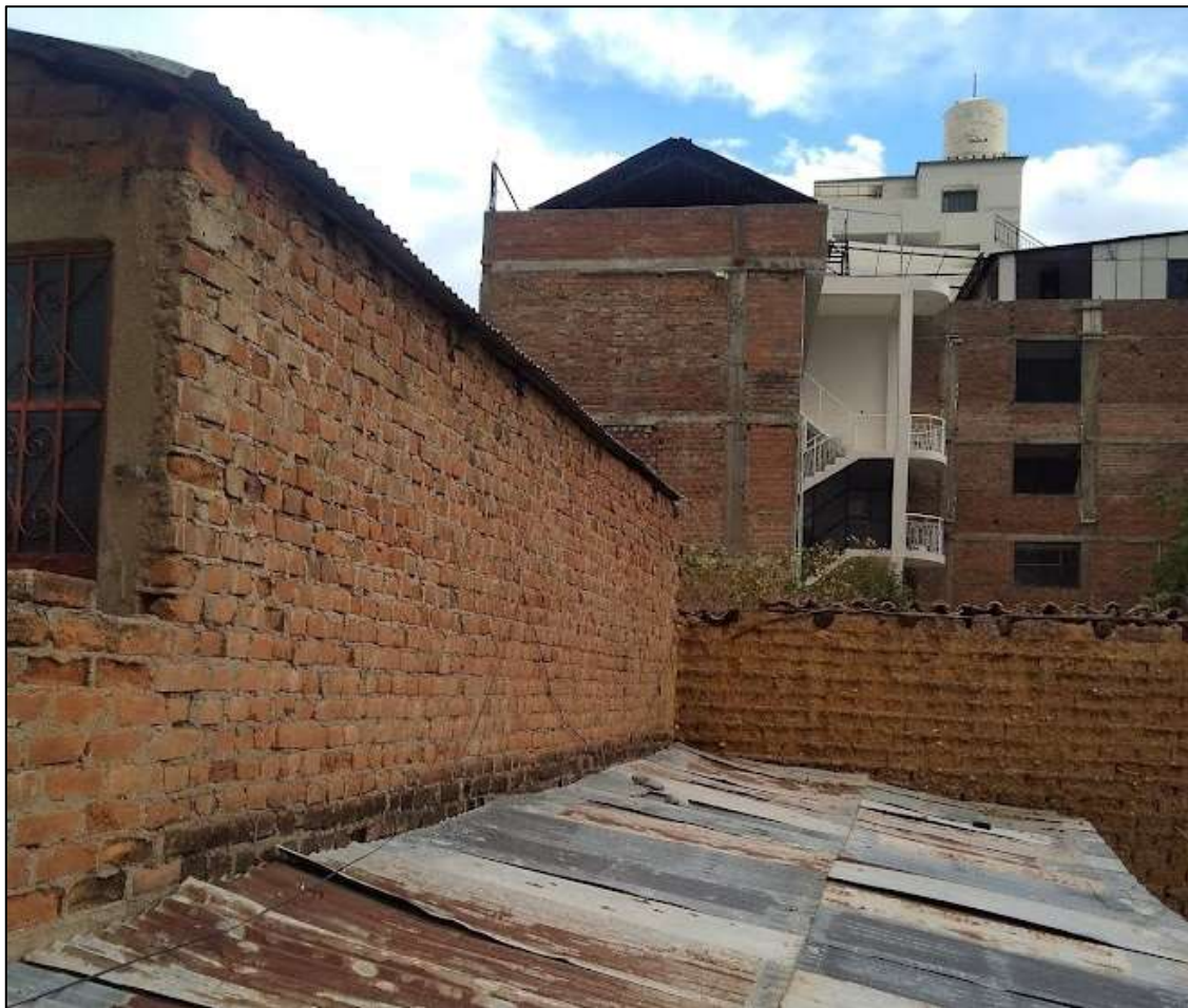
Figura 2.3. Edificaciones de albañilería en el distrito de El Tambo – Huancayo.
