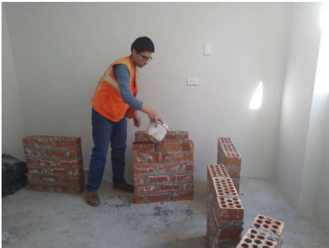
Fotografía 32. Curado de muretes.
