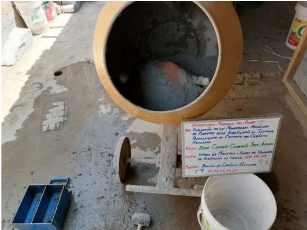
Fotografía 21. Mezclado del mortero con 9 % de sustitución del cemento por cerámico reciclado.
