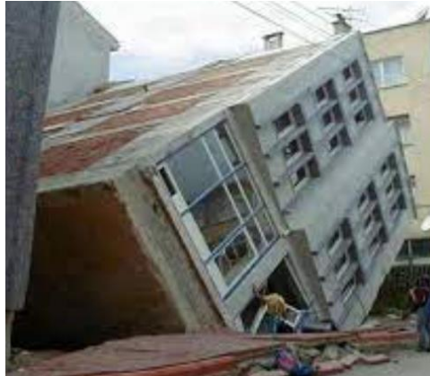
Figura 8 Volteo de un edificio por falla de cimentación
