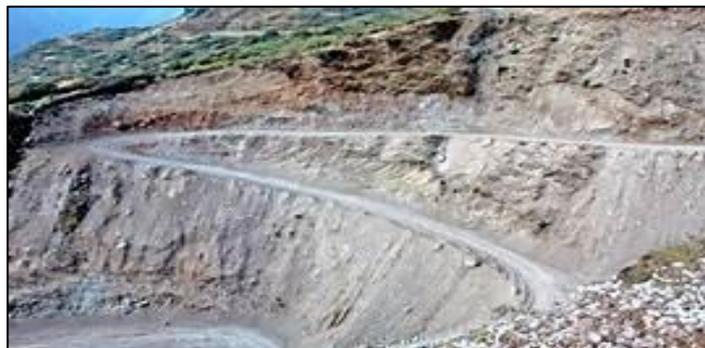
**Figura N° 1:**Carretera de la Provincia de Boyaca -Colombia en el que se muestra desprendimiento de material granular de la vía.
