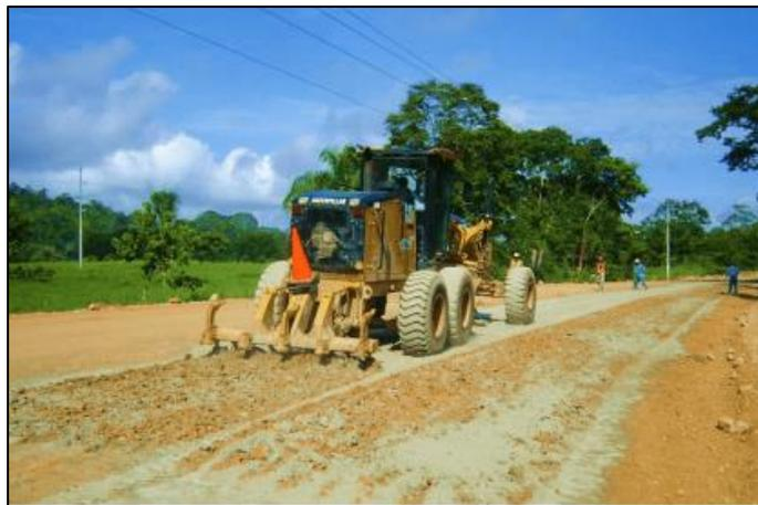
**Figura N° 10:** Estabilización de suelos con cal
