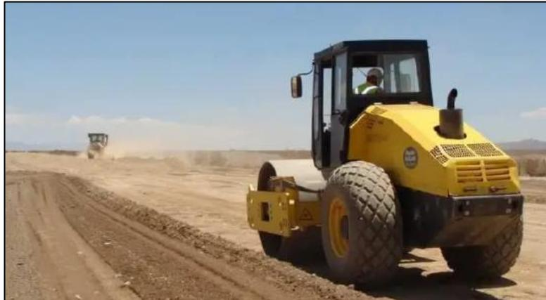
**Figura N° 8:** Estabilización de suelos por un proceso mecánico
