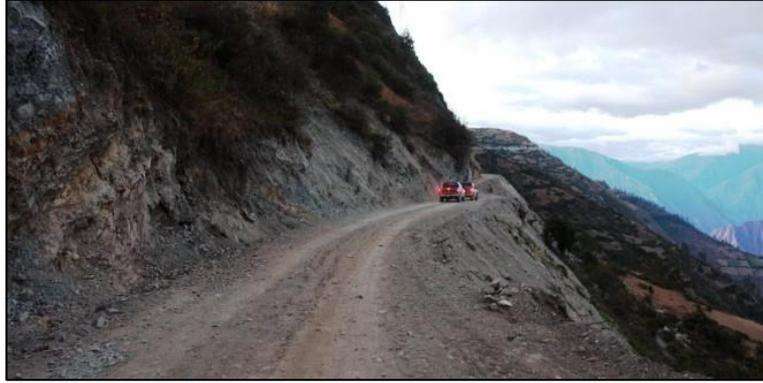
**Figura N° 2:** Desprendimiento de material granular por falta de cohesividad de en tramos de carretera de Abancay
